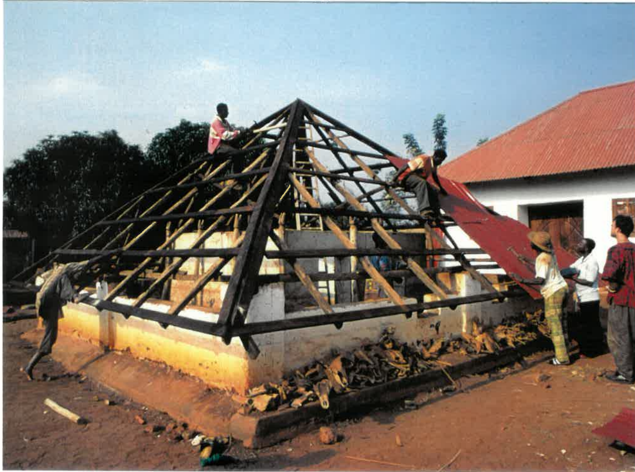
Reprise de la toiture du Djé-Ho de Glélé lors de l'atelier-formation de janvier 1996.
