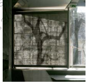
Paroi en blocs de béton translucide, Litracon
