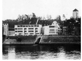
Logements à Saint-Alban-Tal Diener et Diener 1986
