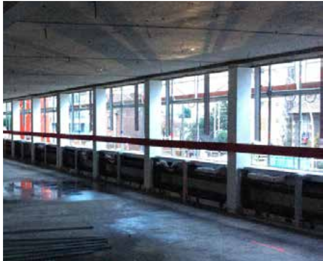
photo A : poteaux vue depuis l'intérieur du bâtiment
