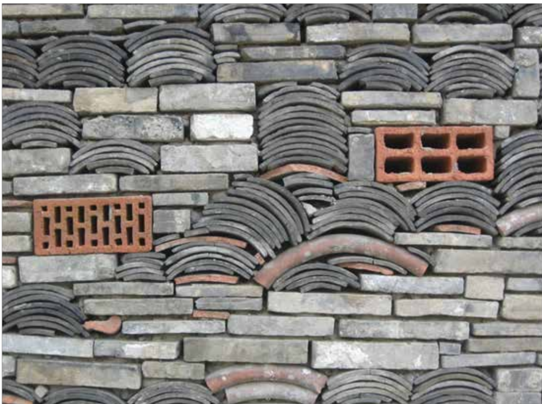
Wang Shu. Ningbo Museum Réutilisation de tuiles et briques dont la mise en œuvre a été étudiée pour mettre en valeur une technique d'assemblage du réemploi.
