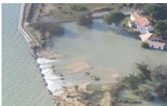
Figure 4 : (a) Franchissement (© F. Tanneau), (b) Débordement (© Torillec) (c) Rupture (© DDTM 17)
