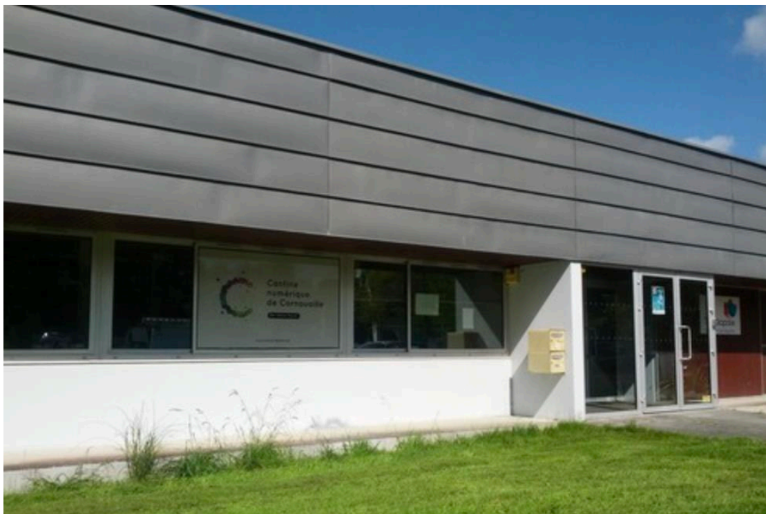
Fig. 1 : La Cantine Numérique Quimper
