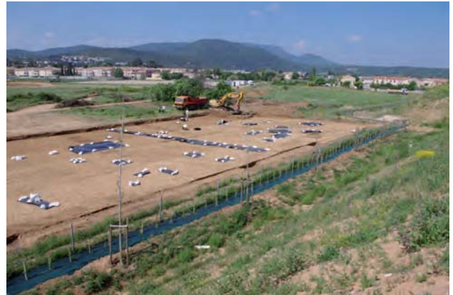
b : Décapage mécanique de la Zone 1
