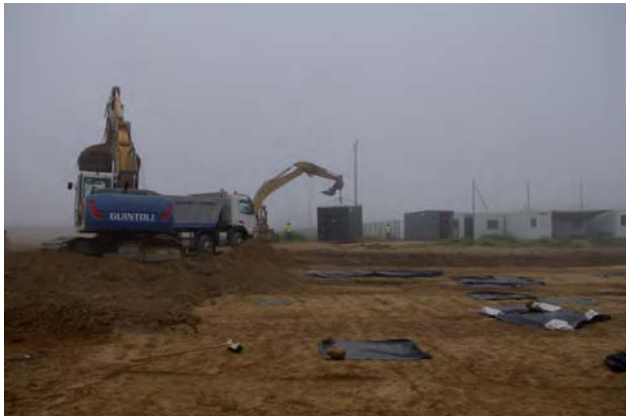
c : Fin du décapage mécanique de la Zone 2
