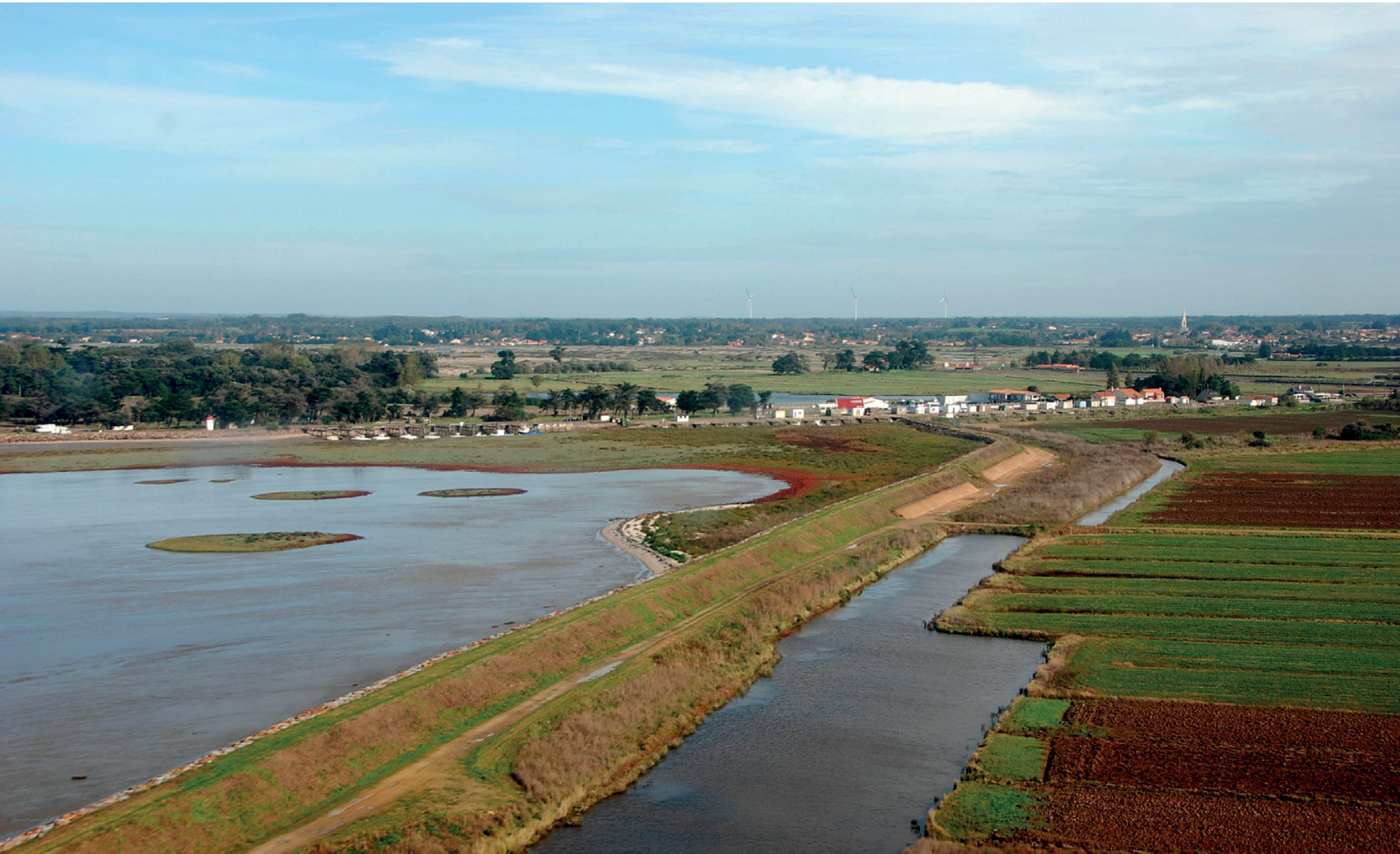
Vue aérienne de la digue de la Parisienne. © Patrice Baldau-Bouin
