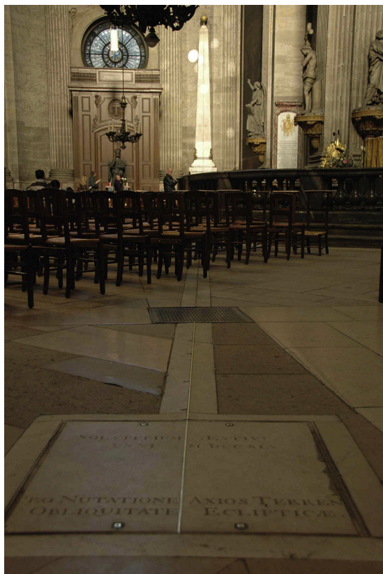
Fig. 6. Vue de la méridienne de l'église Saint-Sulpice à Paris. Construite pour mettre en évidence la nutation, cette méridienne se prolonge verticalement sur un obélisque où l'on observait la tache solaire au solstice d'hiver.
