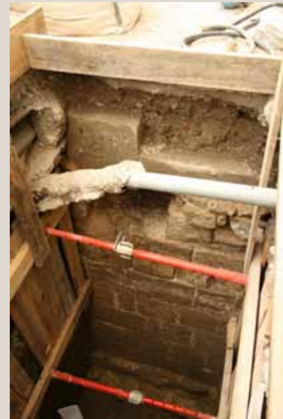
1. Enceinte de Philippe-Auguste dans l'Hôtel de la Monnaie, quai de Conti à Paris. Vue des contraintes du diagnostic et élévation du mur d'après la modélisation en 3D.
