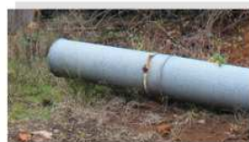
Tuyaux d'évacuation métallique
