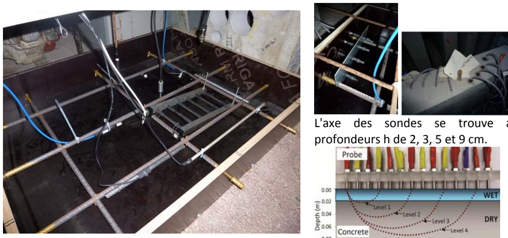
Figure 2 : Instrumentation des dalles avec différents capteurs.
