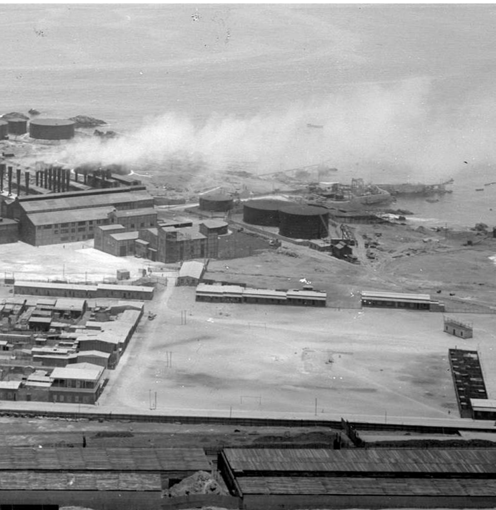
Instalaciones de la termoeléctrica en la Península Algodonales de Tocopilla, 1925. Se aprecia la desaparecida Villa Esmeralda, también conocida como La Colonia.
