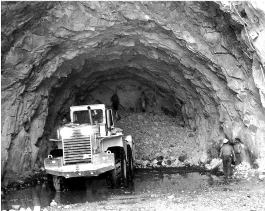
Inicio de la construcción del túnel, 31 de marzo de 1993.
