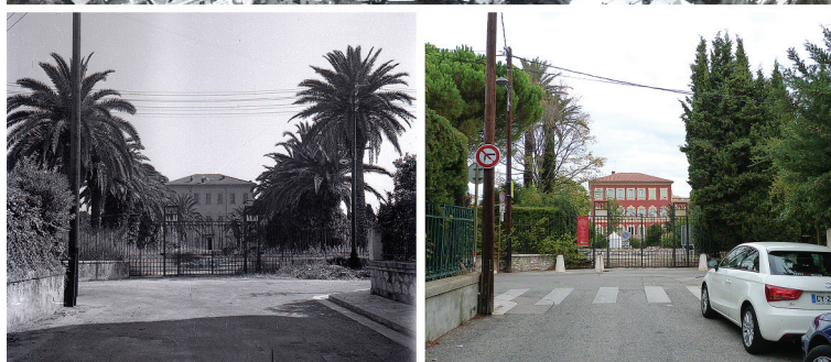
Fig.10. L'alignement de palmiers au Sud de l'ancien domaine Garin de Cocconato. En haut : photographie aérienne vers 1950, (Archives municipales de Nice). En bas : Le changement d'aspect et de destination de l'ancienne entrée Sud de la villa Garin de Cocconato et son alignement de palmiers. À gauche : photographie provenant des Archives municipales de Nice vers 1950, à droite : photographie réalisée par Marie Hérault le 17 septembre 2014.
