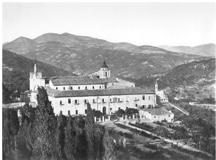
Fig.22. Le monastère de Cimiez et le petit bâtiment rural. Photographie de Charles Nègre, 1863. Collection du Théâtre de la photographie et de l'image, Nice.
