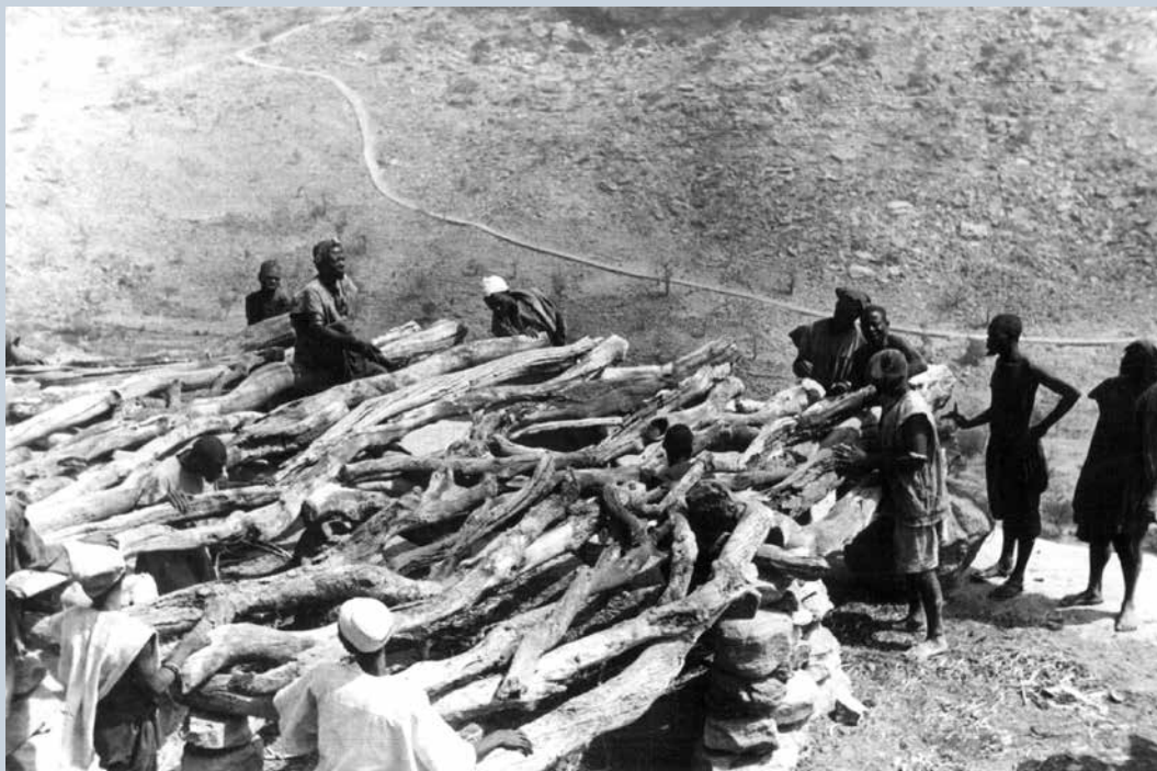
4. Structure en construction du toit d'une maison des hommes, toguna. Dogon. Gogoli, Mali
