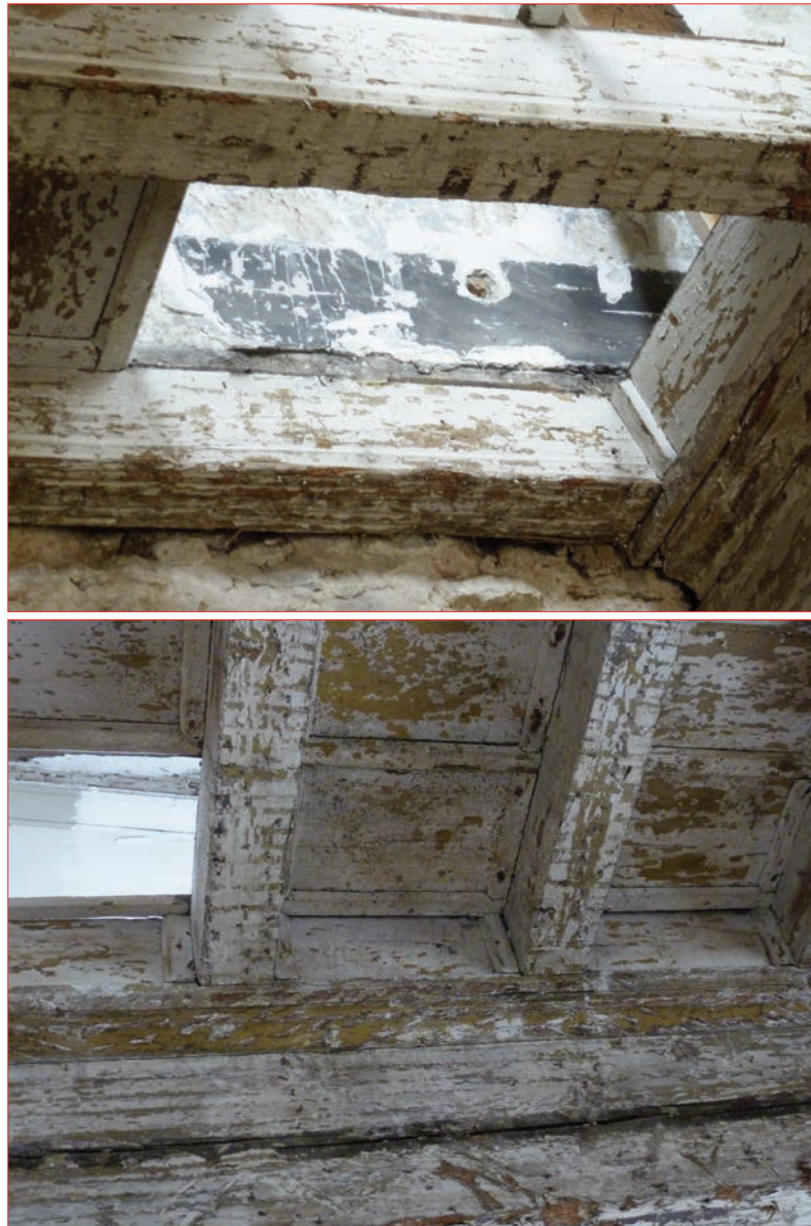
Photo 8 (en haut) : Détail des solives moulurées, plafond du RDC, aile sud. Au premier plan, solive moulurée sur une seule face.
