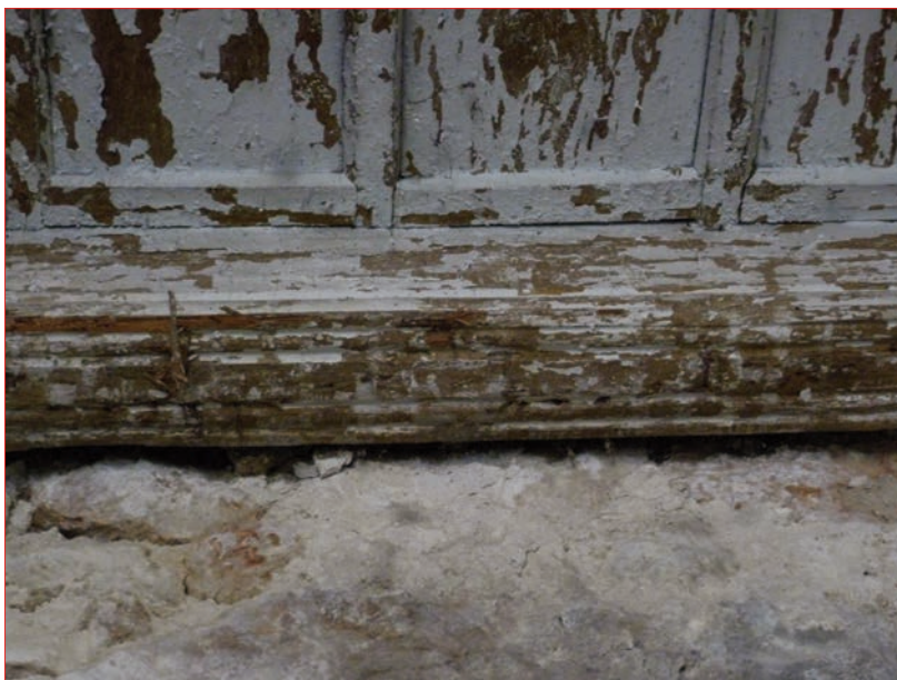
Photo 6 (en haut) : Plafond du premier niveau de l'aile sud, solive moulurée contre le mur. Photo 7 (en bas) : Détail de la solive moulurée, plafond RDC, aile sud.
