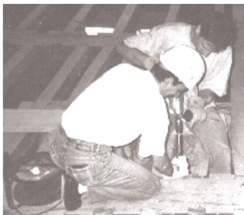
Photo 1 (Lavie) : Prélèvement à la tarière électrique
