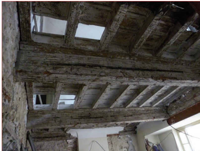
Photo 4 (en haut) : Planche taillée à la doloire, avec marquage. Plancher du seconde étage aile sud.
