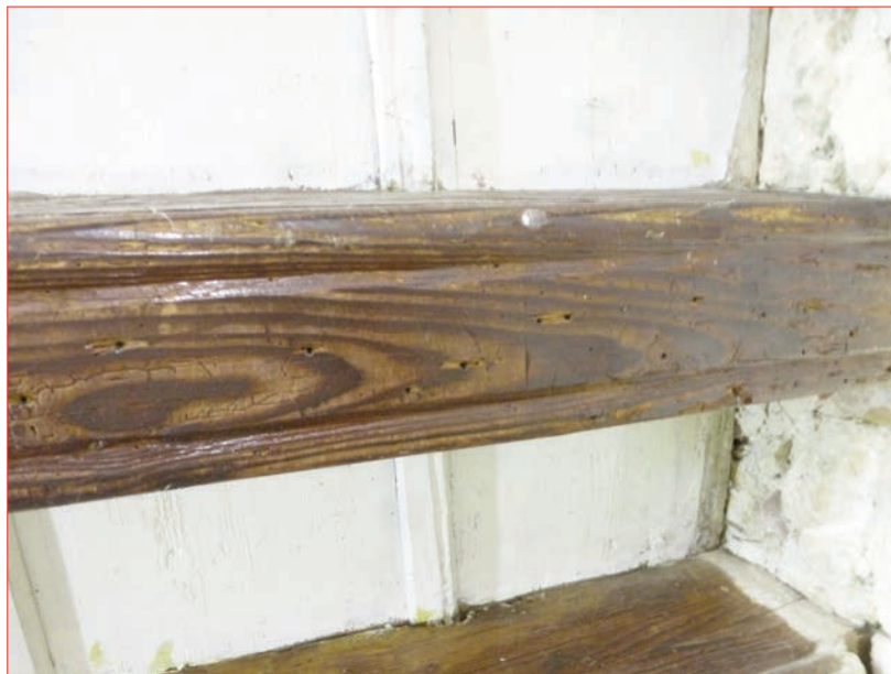
Photo 11 (en haut) : Vue du plafond du premier niveau de l'aile ouest.
