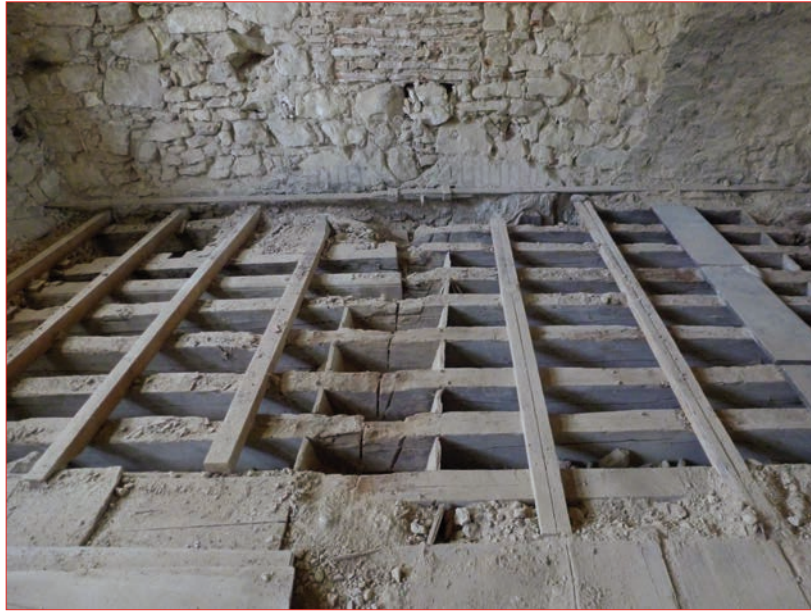
Photo 15 : Vue du plafond du premier étage de l'aile est, depuis le second étage.
