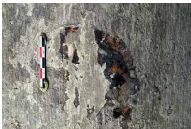
ill. 8 : Travée 4 nord, pilier ouest (P_2), colonne engagée sud : décor fibreux noir et couche picturale rouge.
