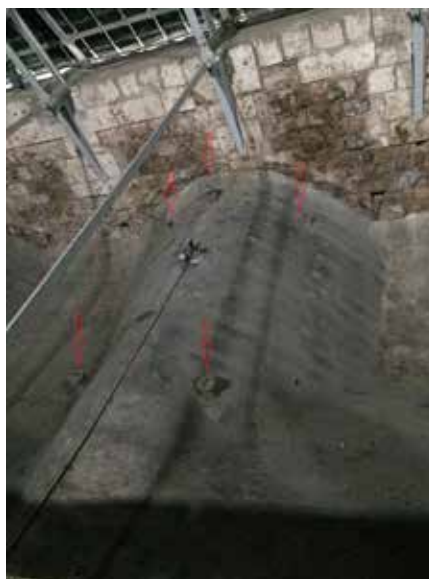
Fig. 2 & fig. 3 : Chartres, Notre-Dame, comble de la cathédrale. Vue générale de l'extrados des voûtes et localisation des conduits traversants la voûte et obturés par des bouchons.
