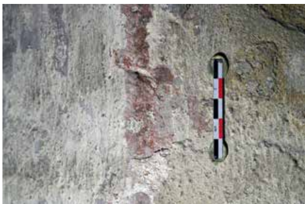
ill. 12 : Pilier entre les travées 7 et 8 (P_6) : détail de la polychromie sur la colonne engagée sud. (droite)
