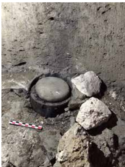
Fig. 4 & fig. 5 : Chartres, Notre-Dame, combles d'une chapelle rayonnante. Tube de bois sortant du conduit traversant la voûte et coiffé de son bouchon.
