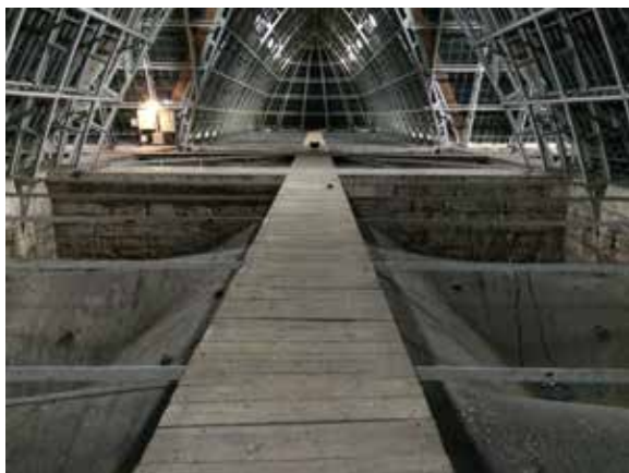
Fig. 2 & fig. 3 : Chartres, Notre-Dame, comble de la cathédrale. Vue générale de l'extrados des voûtes et localisation des conduits traversants la voûte et obturés par des bouchons.
