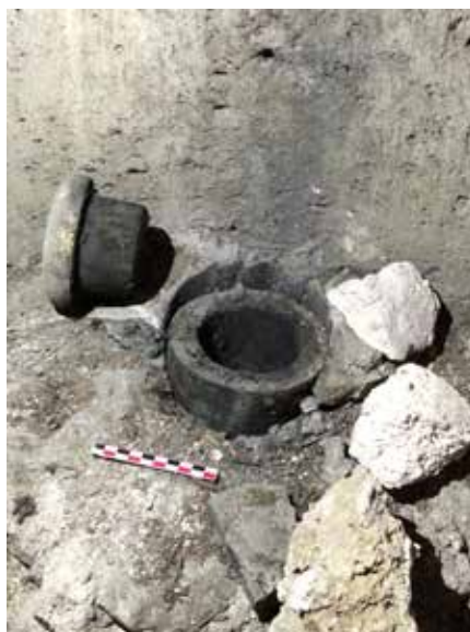
Fig. 4 & fig. 5 : Chartres, Notre-Dame, combles d'une chapelle rayonnante. Tube de bois sortant du conduit traversant la voûte et coiffé de son bouchon.
