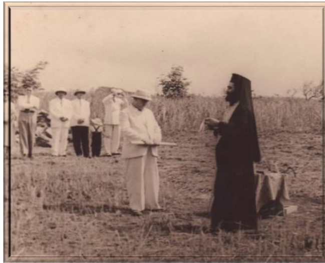
Figure 1 : Pose de la première pierre pour la construction de la cathédrale l’« Annonciation de la Mère de Dieu » au quartier Bastos à Yaoundé en 1953. Source : Gregorios (2009 : 11).
