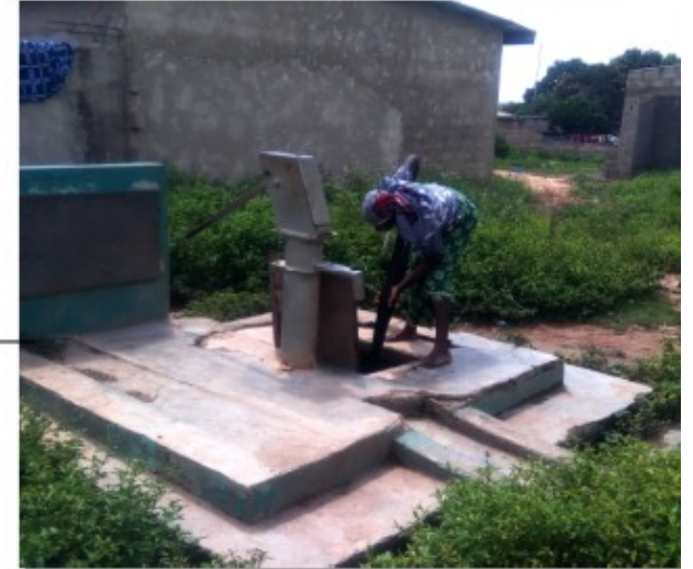
Puits avec PMH à Tolakouadiokro
