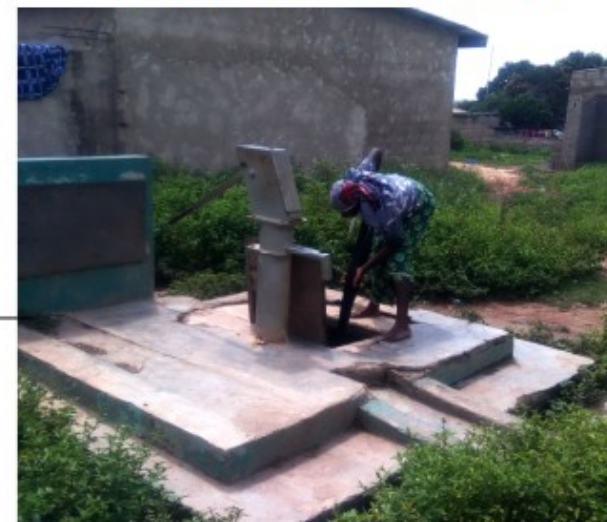
Puits avec PMH à Tolakouadiokro
