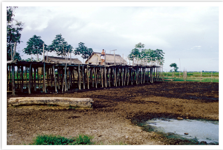
Figura 8. No verão, maromba em palafitas altas. Lugar onde fica o gado durante a cheia. Costa do Parú, Óbidos. Fotografia: Mark Harris, 1992-1994.
