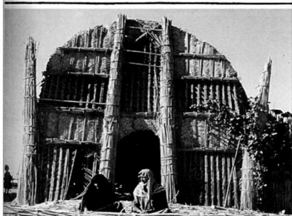
Fig. 1 : En haut, mudhif servant d'étable (à gauche) et de magasin (à droite) avec des vases de stockage, empreinte de sceau, Uruk récent / Djemdet Nasr, 3200-2900 ; en bas, mudhif en roseau dans le sud de l'Irak (d'après FALES F. M. 1989, Prima dell'alfabeto. La storia della scrittura attraverso testi cuneiformi inediti , Studia documenta 4, Venise : Erizzo).
