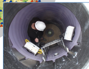
Fig 4. Installation du sismomètre dans le puits 3 (Avril 2013)
