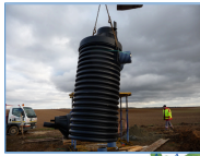
Fig 1. Installation d'un tube PEHD après excavation (Nov. 2012)
