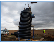
Fig 1. Installation d'un tube PEHD après excavation (Nov. 2012)
