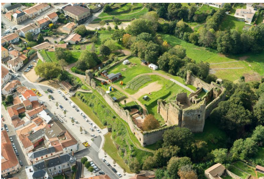
Fig. 1. Le château de Talmont, vue aérienne. Crédits : Château de Talmont, 8 rue du château, 85440 Talmont Saint-Hilaire.
