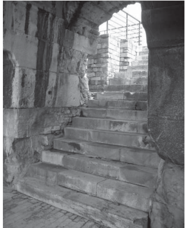
Fig. 3 – Implantation des latrines pour femmes
