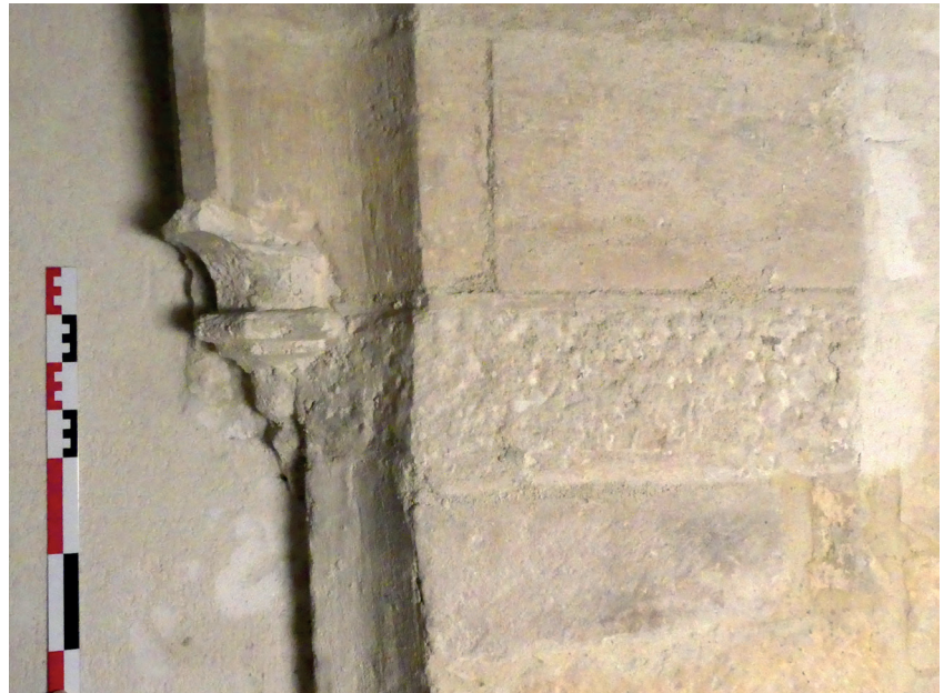
Porche du sud-ouest Profil des nervures de la croisée d'ogives
