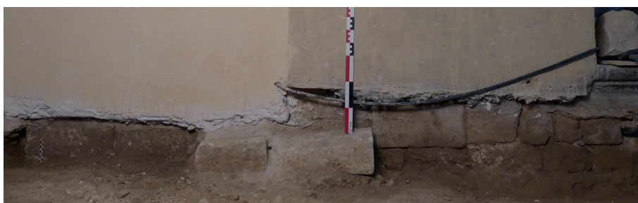
Fig.9 - Fondation du mur septentrional MR1002 de l'église, dans son état roman (US 1138) au nord-ouest du transept © Inrap cliché O. Maufrais
