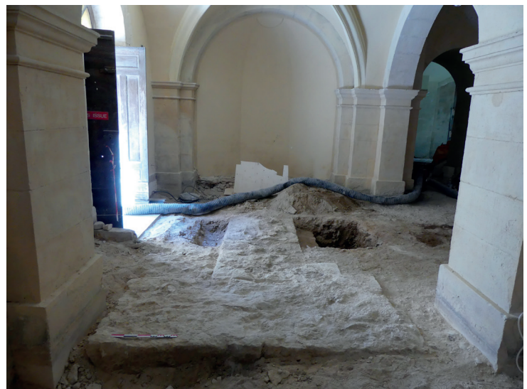
Fig.79 - Vue d'ensemble des murs du XII e s. conservés sous le collatéral du sud. Au second plan, le sondage 8 qui en a dégagé le flanc (vue de l'est)
