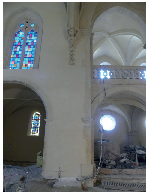
Fig.55 - Le pilier de séparation des deux dernières travées de la nef au XIX e s., à l'est, avec son culot orné dans un style néo-baroque et le départ de l'arc doubleau. Au sol, sous la mire graduée, on observe le vestige du pilier antérieur SU1103 qui supportait la voûte d'époque moderne
