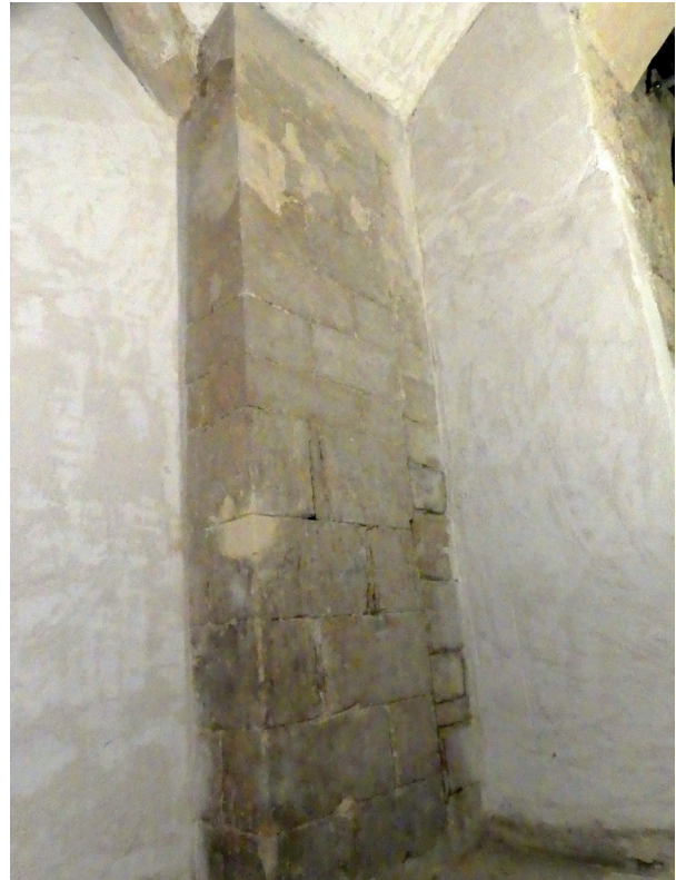
Fig.26 - Détail de la face sud du pilier médiéval SU1001, contrebutée à droite (à l'est) par la maçonnerie US 1003 sur lequel s'adosse l'extrémité moderne US 1002 du mur nord de la nef Mr1002 (tout à fait à droite, ici enduit)
