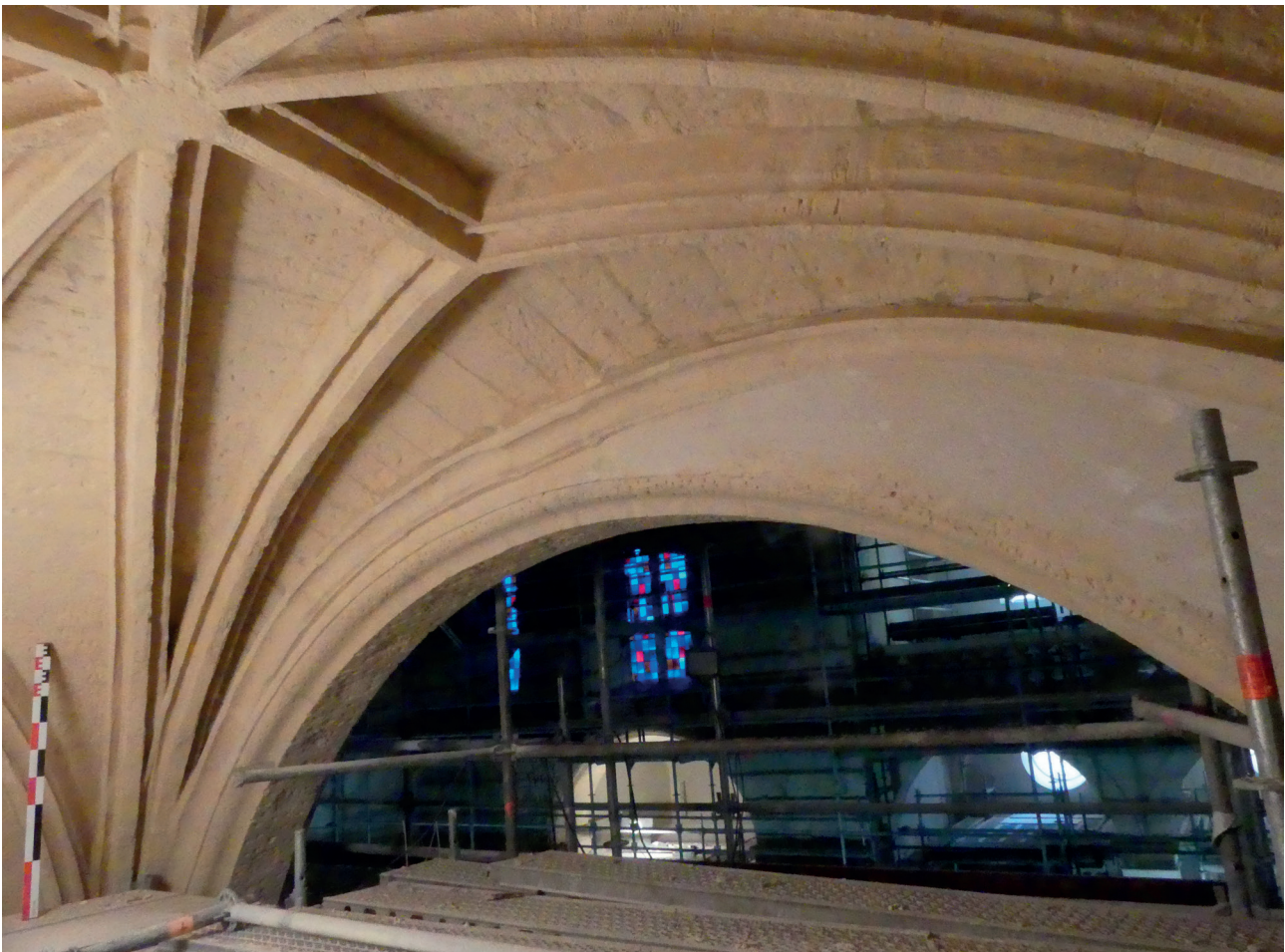
Fig.48 - La voûte 1023 de la chapelle 3 : réalisation moderne reprenant le style des chapelles 1 et 2 du bas Moyen Âge © Inrap cliché M. Ott
