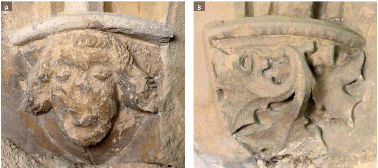
Fig.50 - Les culots gothiques de la croisée d'ogives moderne de la sacristie © Inrap clichés M. Ott
