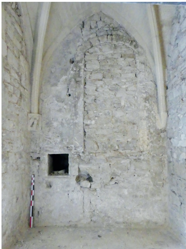
Fig.39 - Détail du mur oriental MR1056 du porche (POR1054), bâti en deux temps. À gauche (au nord), la partie ancienne certainement chaînée au mur de façade septentrionale MR1065. À droite, la partie plus récente
