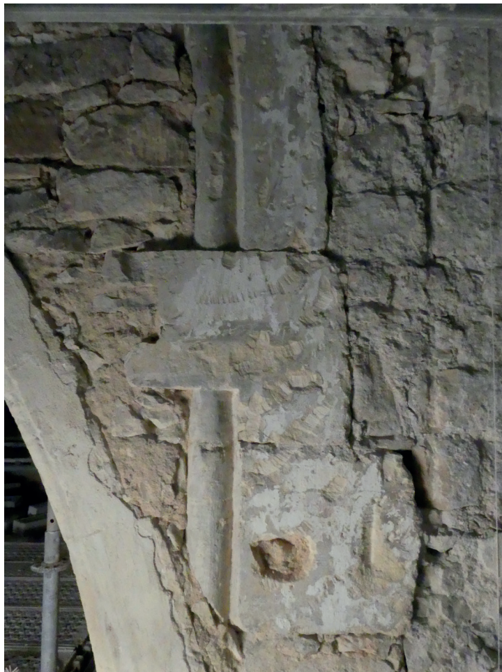
Fig.28 - Détail de la partie orientale du vestige de la fenêtre (US 1026) : de bas en haut : sommet du montant, extrémité de traverse et départ d'arc brisé
