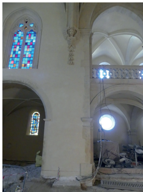
Fig.55 - Le pilier de séparation des deux dernières travées de la nef au XIX e s., à l'est, avec son culot orné dans un style néo-baroque et le départ de l'arc doubleau. Au sol, sous la mire graduée, on observe le vestige du pilier antérieur SU1103 qui supportait la voûte d'époque moderne
