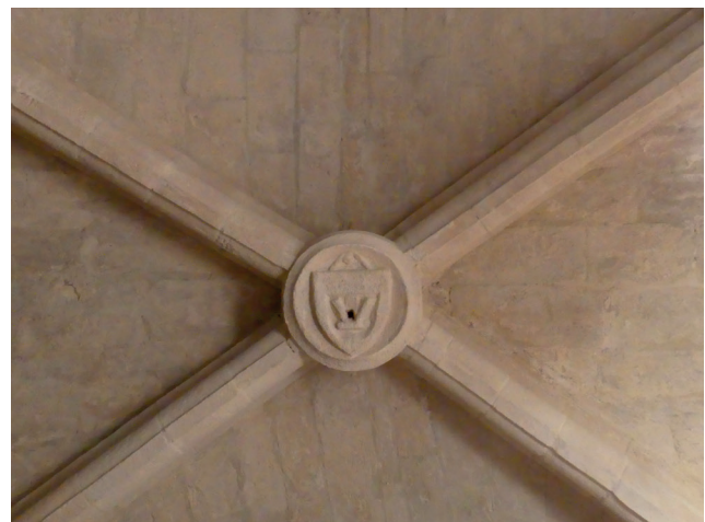
Fig.33 - Détail de l'écusson sur la clef de voûte de la chapelle 1 (US 1009)
