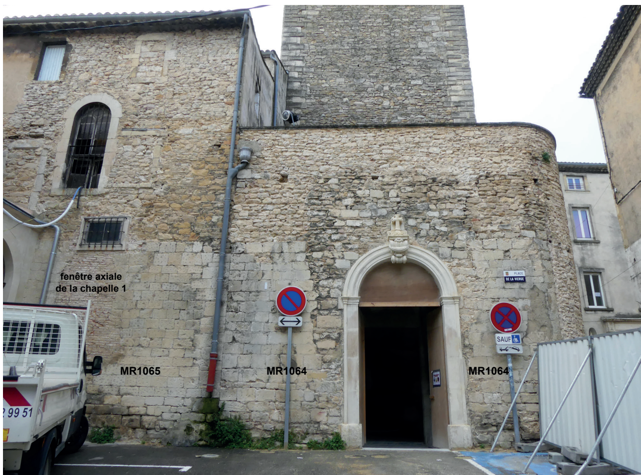
Fig.30 - La partie occidentale du mur septentrional de l'église Saint-Jean-Baptiste. A gauche le pan MR1065 fermant la chapelle 1 avec sa fenêtre axiale rebouchée tardivement par des briques pour servir de niche. A droite le pan MR1064 qui ferme le porche du nord-ouest © Inrap cliché O. Mauftras, infographie F. Robin
