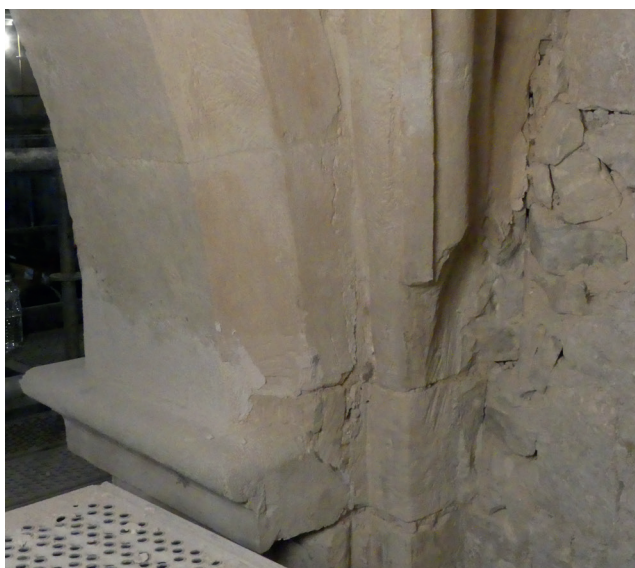
Fig.36 - Détail du culot bûché de réception de l'ogive dans l'angle sud-ouest de la chapelle 2 (CHA1013)
