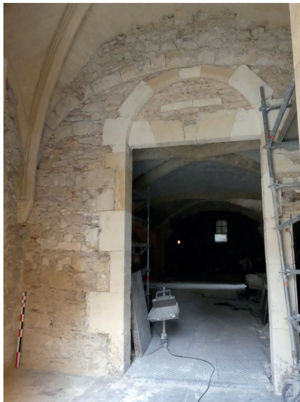
Fig.40 - Détail de la cloison MR1055 du porche (POR1054), bâtie en sous œuvre de l'arc de décharge
