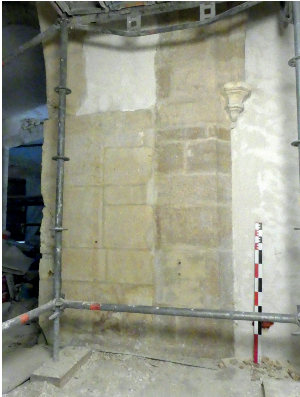
Fig.25 - L'angle sud-ouest de la chapelle 1 avec, au centre, en grand appareil de taille de grès beige, le pilier 1004 et le culot de réception d'une ogive de la voûte. À gauche (au sud), le pan de mur moderne US 1002 constituant le mur gouttereau septentrionale MR1002 de l'église et remplaçant le pan de mur plus ancien 1021b du bas Moyen Âge contre lequel venait s'appuyer la chapelle
