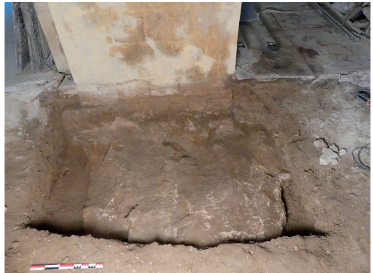
Fig.73 - Vue d'ensemble du sondage 6 : la semelle de fondation MR1114 recoupée de part et d'autre par deux sépultures
