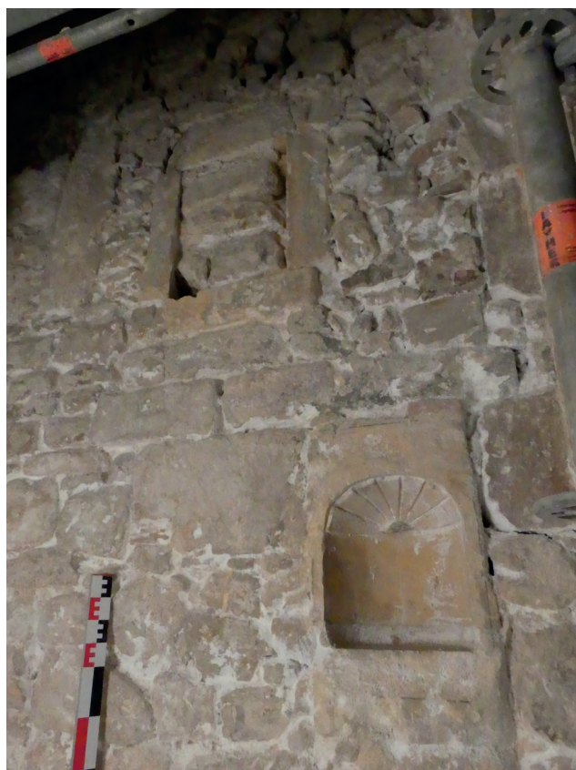
Fig.37 - La petite niche à l'entrée de la chapelle 2, dans l'angle sud-est et la fenêtre (bouchée) qui la surmonte. Vue de l'ouest
