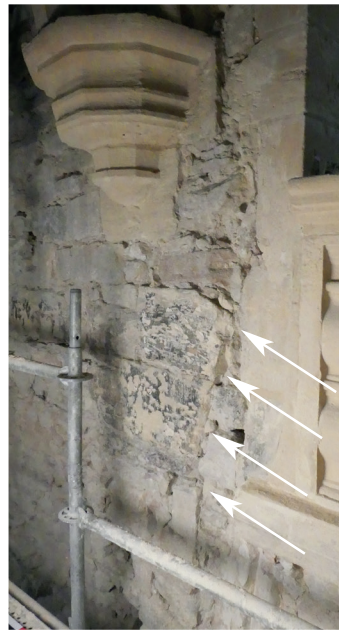
Fig.18 - Détails du piédroit 1021a et du départ de son arcature (premier état du mur septentrional MR1002), ennoyé dans des pans de maçonnerie plus récente, du bas Moyen Âge et de l'époque moderne
