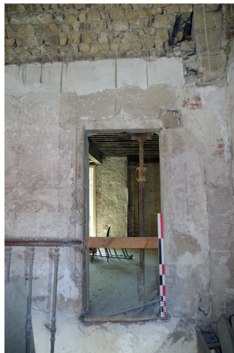
Figure 63 : Porte de communication entre la pièce 2.8 et la galerie sud, au deuxième étage ; cliché : D. Jouneau
