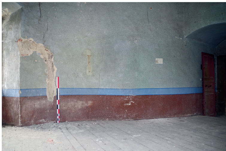
Figure 27 : Baie avec arrière-voussure en plein cintre, au premier étage de la tour nord ; cliché : D. Jouneau
