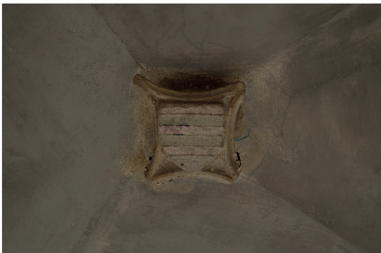
Figure 71 : Clé pendante de la voûte nord de la galerie est de la cour ; cliché : D. Jouneau
