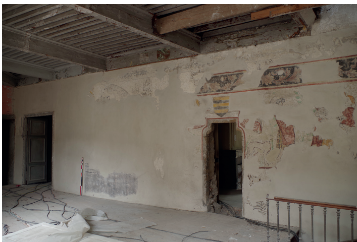
Figure 92 : Vue générale du mur sud de la galerie sud, au premier étage ; cliché C. Collomb
