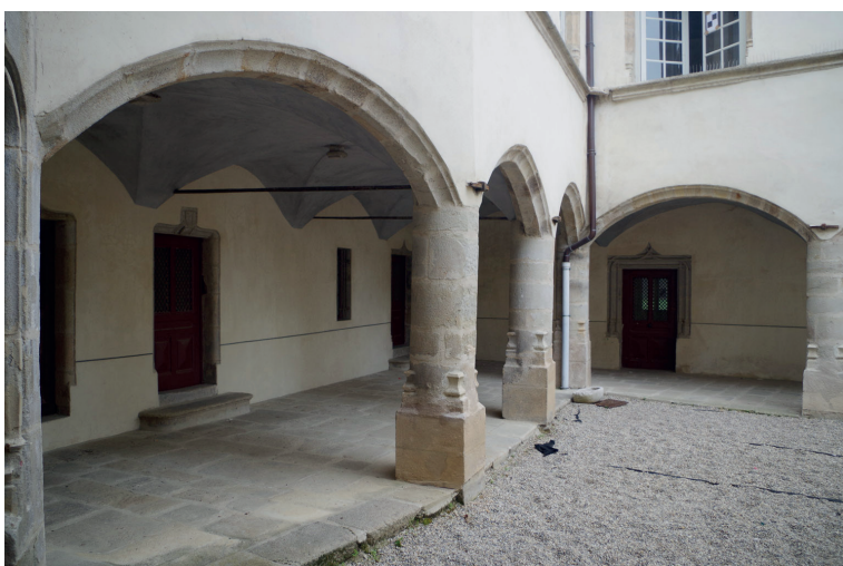
Figure 72 : Galerie orientale de la cour, vue du nord ; cliché : D. Jouneau
