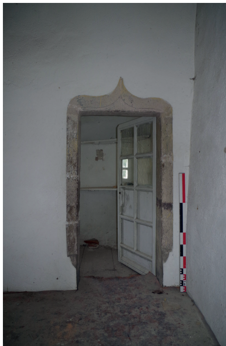
Figure 53 Congé du piédroit sud de la cheminée du rez-de-chaussée du bâtiment nord-ouest ; cliché : D. Jouneau
