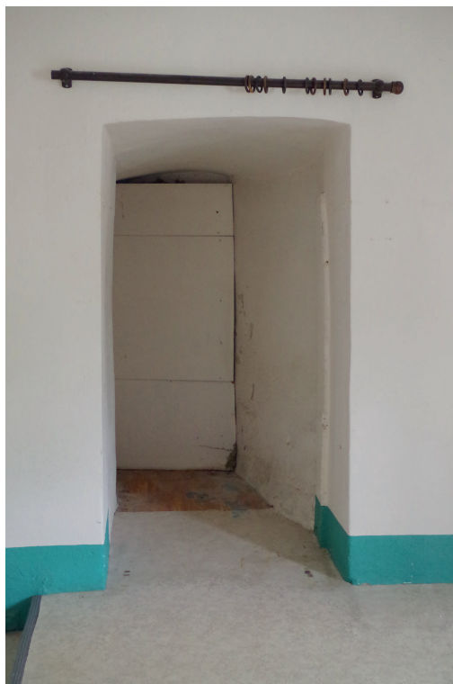
Figure 26 : Porte de communication entre la tour nord et la tour d'escalier ; cliché : D. Jouneau
