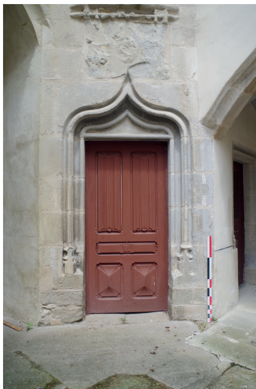
Figure 36 : Porte principale de la tour d'escalier ; cliché : D. Jouneau
