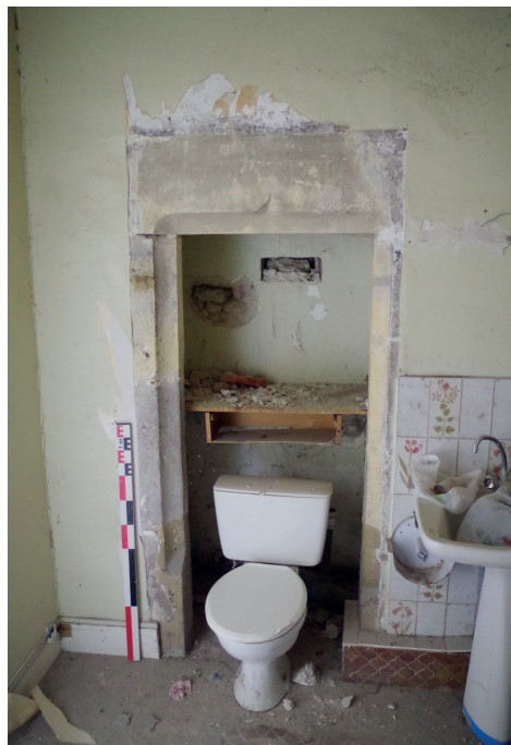
Figure 55 : Porte de communication entre la loggia et le bâtiment nord-ouest, au premier étage ; cliché : D. Jouneau
