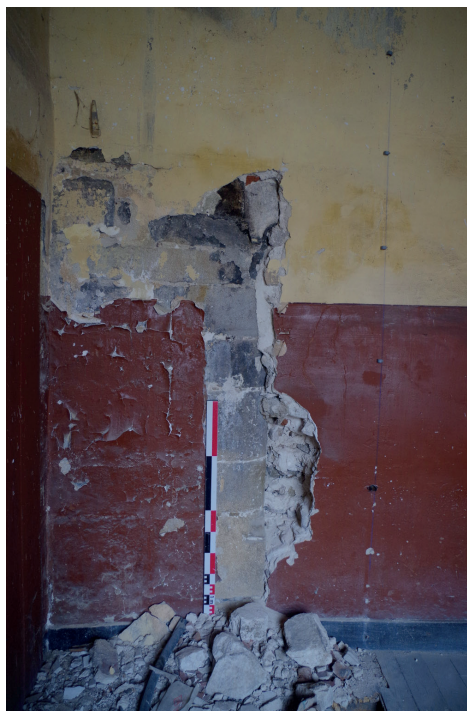
Figure 51 : Congé du piédroit sud de la porte du rez-de-chaussée du bâtiment nord-ouest ; cliché : D. Jouneau
