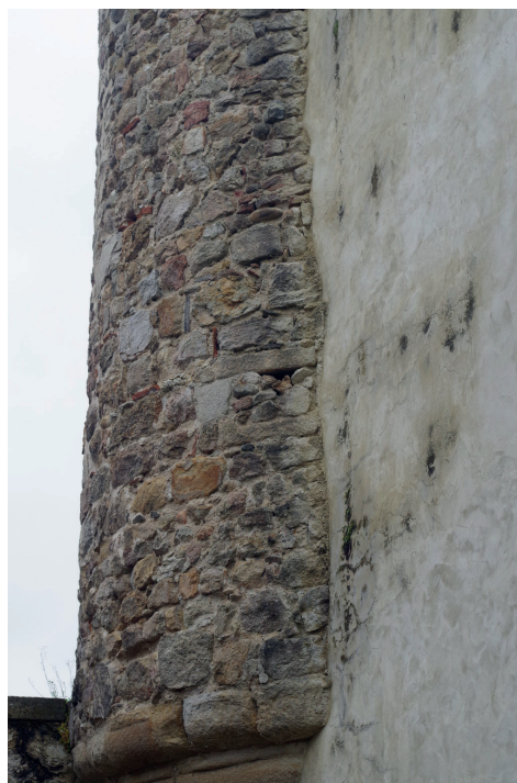
Figure 61 : Bouche à feu en flanquement sud-ouest, condamnée, de l'échauguette ; cliché : D. Jouneau
