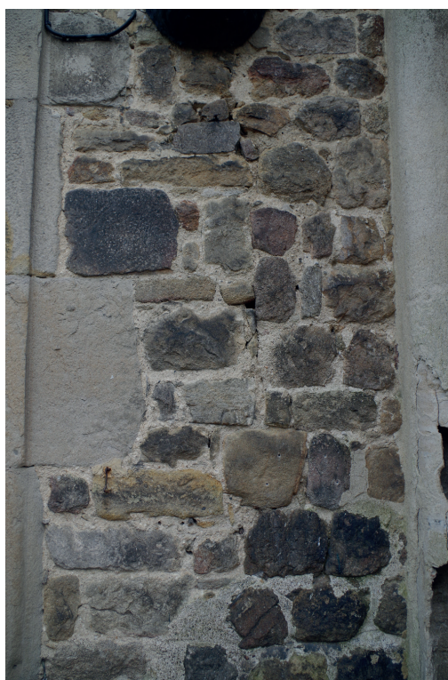
Figure 34 : Césure visible dans le parement externe de la façade nord du corps de bâtiment oriental, au rez-de-chaussée ; cliché : D. Jouneau
