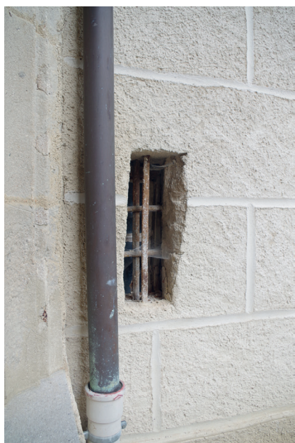
Figure 17 : Fenêtre de tir en flanquement ouest, du rez-de-chaussée de la grosse tour ronde sud-est ; cliché : D. Jouneau
