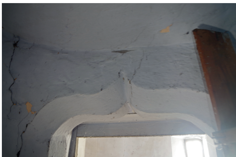
Figure 28 : Tour nord, deuxième étage, pièce 2.16 : arc en accolade de la porte ; cliché : D. Jouneau
