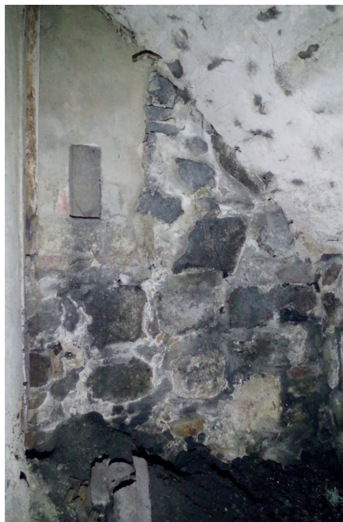
Figure 32 : Soupirail nord des celliers, piédroit ouest ; cliché : D. Jouneau
