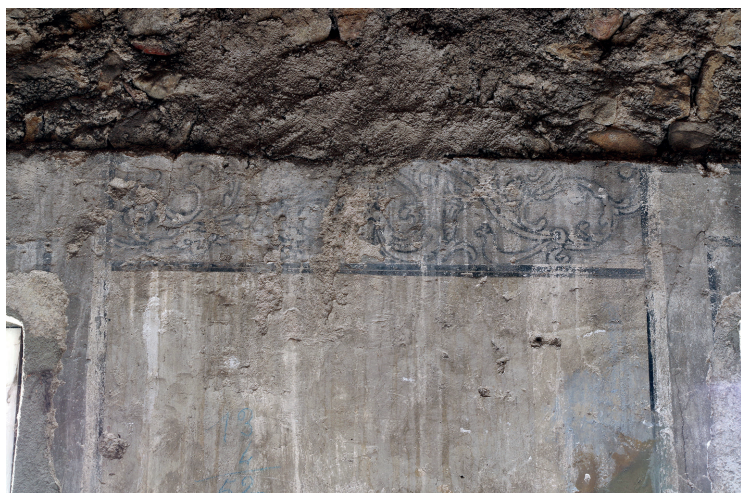
Figure 91 : UD9, frise d'entrelacs en partie haute entre les baies sud et centrale ; cliché C. Collomb
