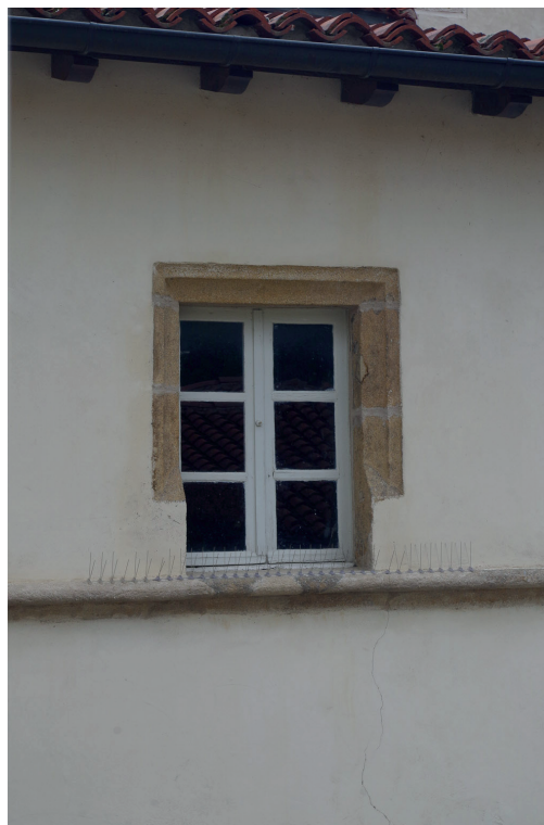
Figure 78 : Baie du premier étage de la galerie sud ; cliché : D. Jouneau
