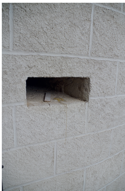
Figure 18 : Bouche à feu en flanquement ouest, du premier étage de la grosse tour ronde sud-est ; cliché : D. Jouneau
