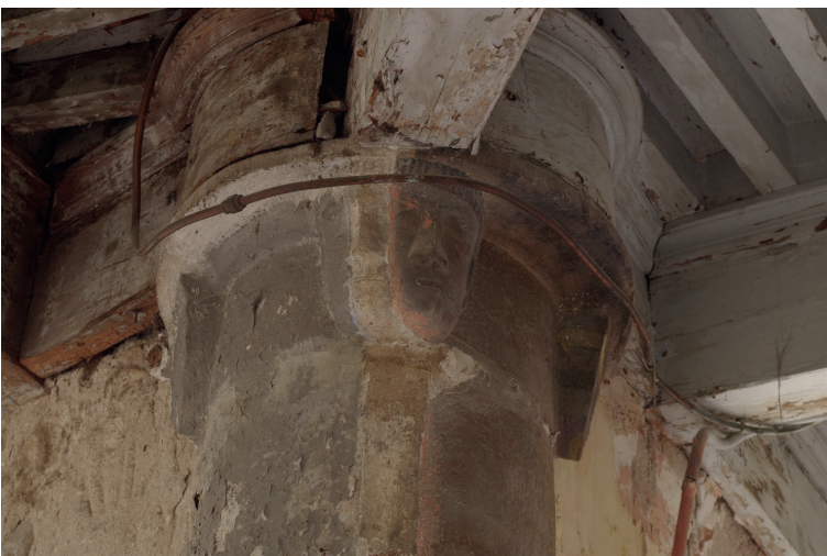
Figure 73 : Détail du chapiteau de la pile d'angle des galeries, au premier étage ; cliché : C. Collomb
