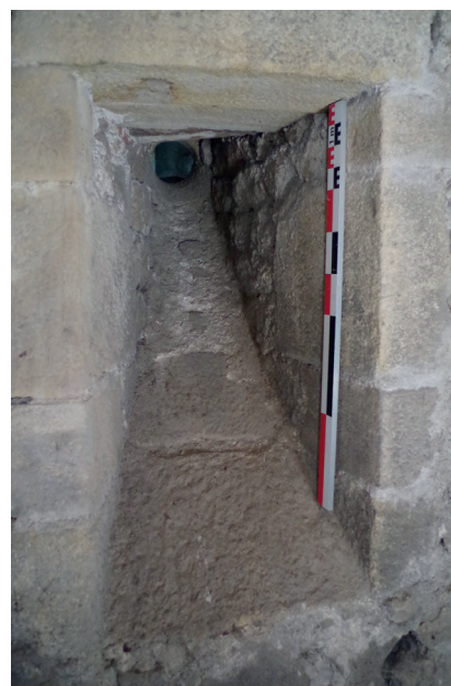
Figure 19 : Canonnière en flanquement sud-est, du deuxième étage de la grosse tour ronde sud-est ; cliché : D. Jouneau
