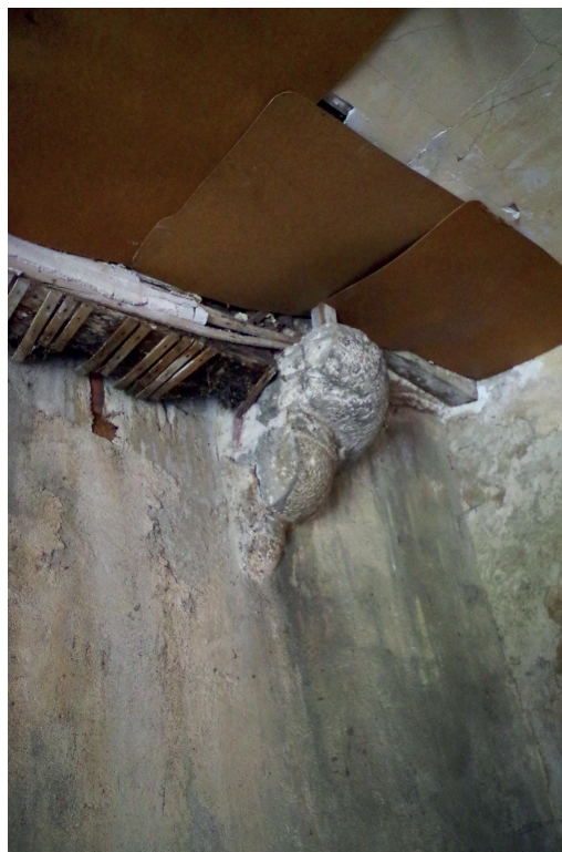
Figure 20 : Vue en contreplongée des latrines des premier et deuxième étages de la grosse tour ronde sud-est ; cliché : D. Jouneau
