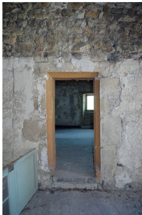
Figure 70 : Porte insérée dans le mur est du bâtiment sud-est, ouvrant sur la galerie sud, au deuxième étage ; cliché : D. Jouneau
