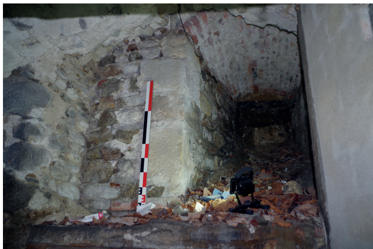
Figure 33 : Vestiges du piédroit est de la baie reprise par le soupirail nord des celliers ; cliché : D. Jouneau
