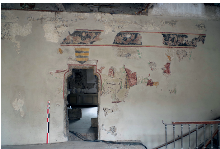
Figure 93 : Vue générale du décor restauré UD1 ; UD2 en partie haute ; cliché C. Collomb
