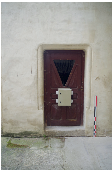
Figure 49 : Porte d'accès du rez-de-chaussée du bâtiment nord-ouest ; cliché : D. Jouneau
