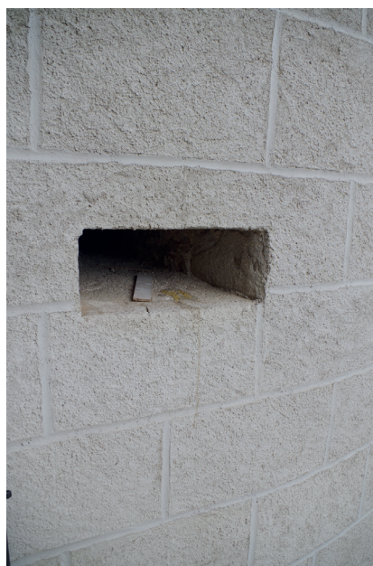
Figure 18 : Bouche à feu en flanquement ouest, du premier étage de la grosse tour ronde sud-est ; cliché : D. Jouneau
