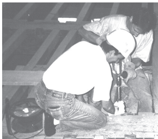
Photo 1 (Lavier) : Prélèvement à la tarière électrique
