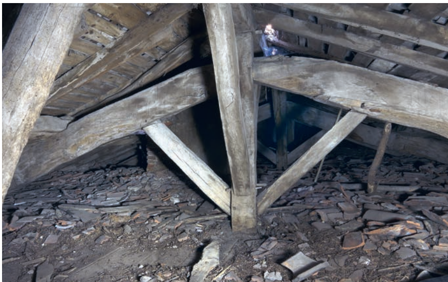
Fig. 20. Maison Graven , comble dont les entrails forment aussi les poutres du plancher qui se développe en dessous.
