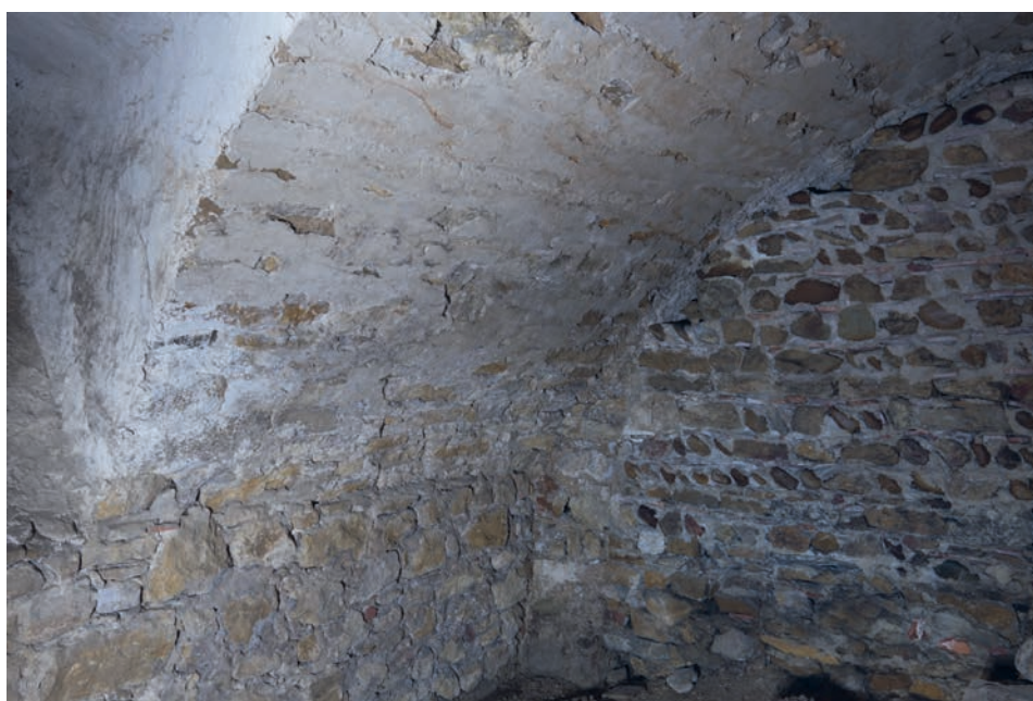
Fig. 9. Maison Graven, niveau de cave, voûte en berceau, retombée dans le mur NORD.
