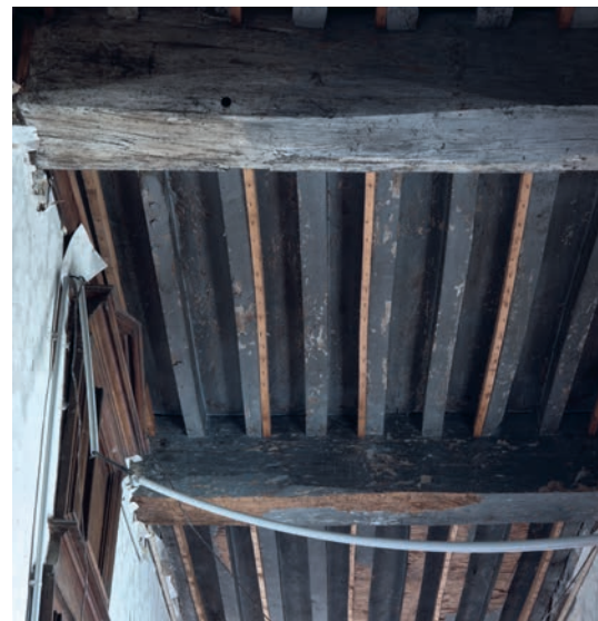
Fig. 4. Maison Graven, plancher, vue depuis l'est.
