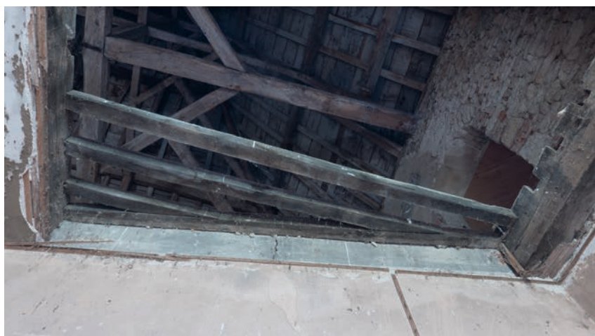
Fig. 17. Tour Dauphine , organisation des solives en fonction du mur de refend longitudinal.
