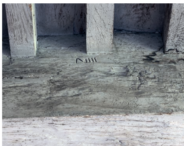
Fig. 25. Maison Graven, poutre 4, face OUEST, marque VIII (9).
