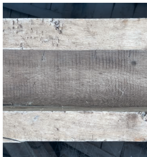
Fig. 29. Tour Dauphine , plancher, ais d'entrevous, sciage mécanique.
