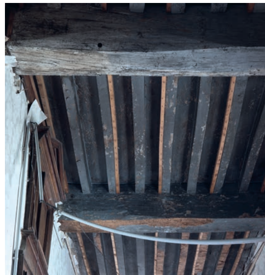
Fig. 4. Maison Graven, plancher, vue depuis l'est.
