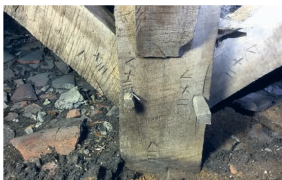
Fig. 23. Maison Graven , ferme 4, face OUEST, poinçon et contrefiches marqués XVII (17) et XVIII (18), pied de poinçon marqué VIII (8).
