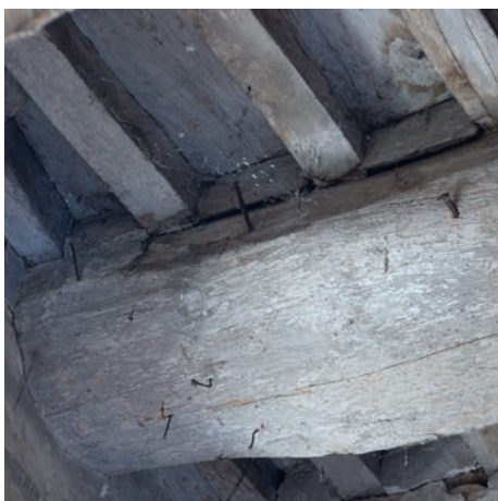
Fig. 26. Tour Dauphine, poutre 2, extrémité flacheuse.
