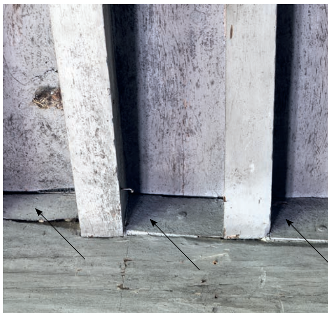
Fig. 27. Maison Graven, plancher, poutre 5, closoirs cloués dans l'entrevous des solives pour dissimuler la partie flacheuse de la poutre.
