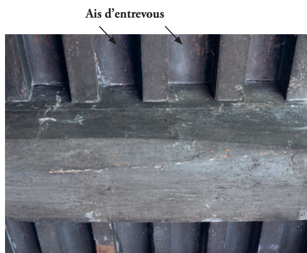
Fig. 6. Maison Graven, ais d'entrevous placés parallèles aux solives.
