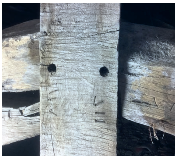
Fig. 28. Maison Graven, ferme 5, trace de sciage manuel.
