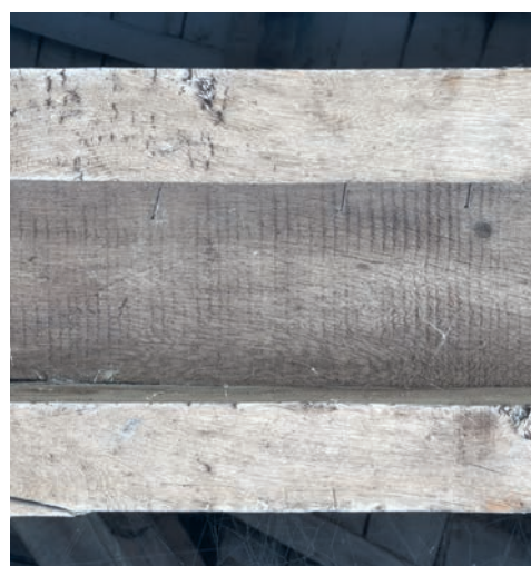
Fig. 29. Tour Dauphine , plancher, ais d'entrevous, sciage mécanique.
