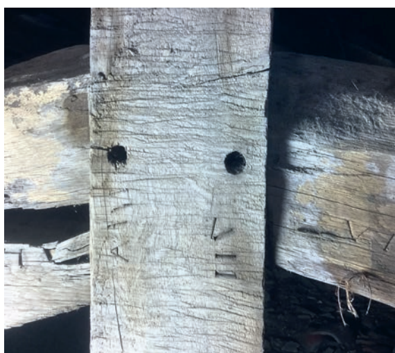
Fig. 28. Maison Graven , ferme 5, trace de sciage manuel.
