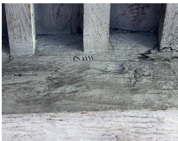
Fig. 25. Maison Graven, poutre 4, face OUEST, marque VIII (9).
