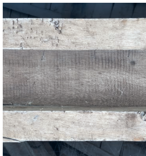
Fig. 29. Tour Dauphine, plancher, ais d'entrevous, sciage mécanique.
