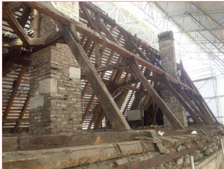
Photo 5 (en haut) : Traces de débitage à la scie manuelle sur le poinçon court de la ferme de croupe nord - bâtiment est.
