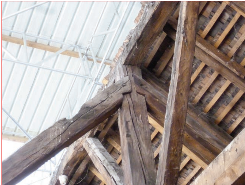
Photo 3 (en haut) : Détail de l'assemblage par adents de 2 éléments constituant une poutre armée - bâtiment est.
