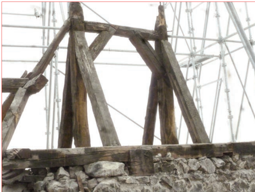
Photo 7 (en haut) : Assemblage à mi-bois entre un aisselier et un arbalétrier - charpente du bâtiment sud.
