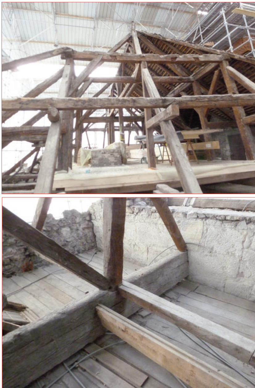
Photo 1 (en haut) : Vue de la charpente du bâtiment est, vers le sud. Photo 2 (en bas) : Poutre armée est, extrémité sud - bâtiment est.
