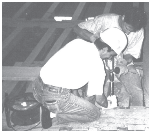
Photo 1 (Lavier) : Prélèvement à la tarière électrique
