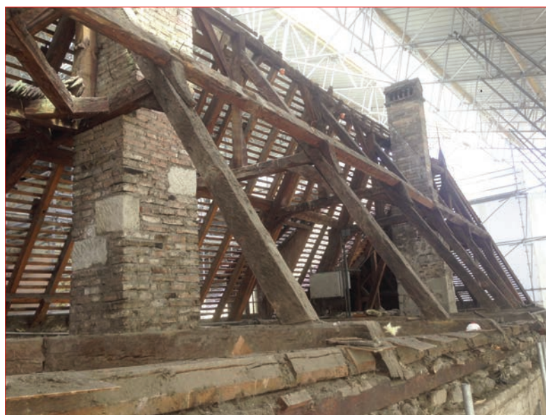
Photo 5 (en haut) : Traces de débitage à la scie manuelle sur le poinçon court de la ferme de croupe nord - bâtiment est.
