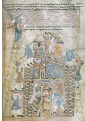
Fig. 6 : Londres, British Library, ms Cotton Claudius B. IV (vers 1025-1050). Détail (fol. 19) : Construction de la tour de Babel. © Emmanuelle JEANNIN, Chantiers d'abbayes , Moisenay, Éditions Gaud, 2008, p. 51. Scène de chantier montrant des ouvriers en activité mais surtout l’approvisionnement de celui-ci à l’aide de paniers et d’auges en bois qui sont passés par des ouvriers montés sur un échafaudage et une échelle.
