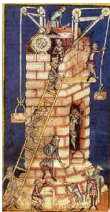
Fig. 4 : Zurich, Zentralbibliothek Ms. Rh 15 (vers 1340-1350) Détail (fol. 6v) : construction médiévale à Altemberg © Emmanuelle JEANNIN, Chantiers d'abbayes , Moisenay, Éditions Gaud, 2008, p. 23. Sur cette miniature, deux ouvriers montent à l'échelle et transportent du mortier dans des seaux.
