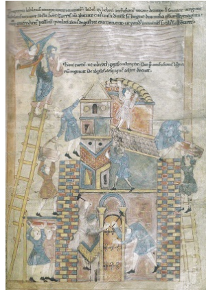
Fig. 6 : Londres, British Library, ms Cotton Claudius B. IV (vers 1025-1050). Détail (fol. 19) : Construction de la tour de Babel. © Emmanuelle JEANNIN, Chantiers d'abbayes , Moisenay, Éditions Gaud, 2008, p. 51. Scène de chantier montrant des ouvriers en activité mais surtout l’approvisionnement de celui-ci à l’aide de paniers et d’auges en bois qui sont passés par des ouvriers montés sur un échafaudage et une échelle.
