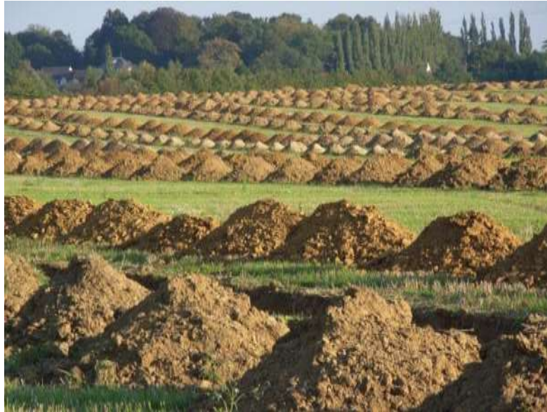
Fig. 1 Tranchées mécaniques de diagnostic, plateau de Saclay
