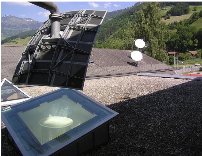
▲ Capteur de conduit de lumière prismatique. Héliobus.
