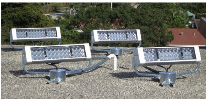
▲ Capteur de conduit de lumière prismatique. Héliobus.
