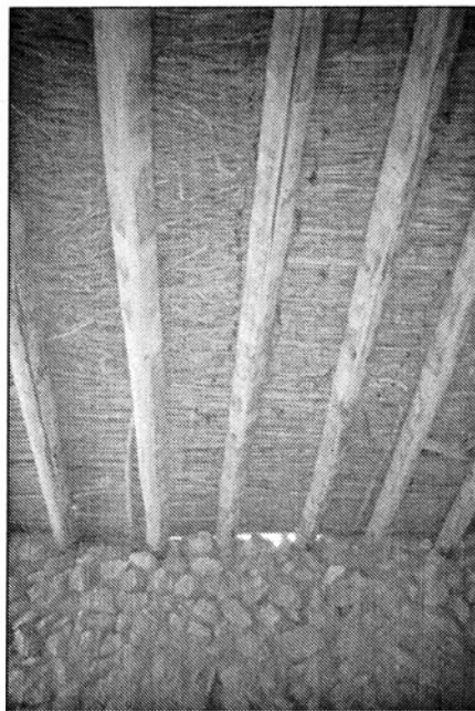
Fig. 8. Charpente d'un toit plat
