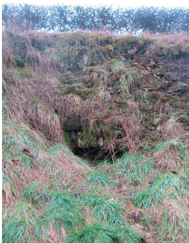
Fig. 47 Pièce voûtées dans le coteau Nord, le long du chemin. © VBG
