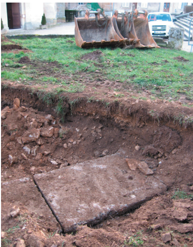
Fig. 30 Vue des dalles de couverture d'un égout © VBG
