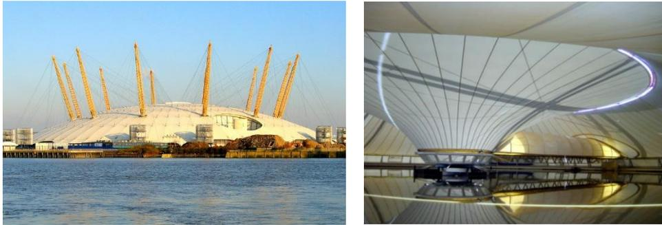
**Figure 6.** Envelopes constituées d'une membrane tendue. Gauche : Stade du Millenium à Londres. Droite : Bassin de décantation de Valenton (©Atelier AFA)
