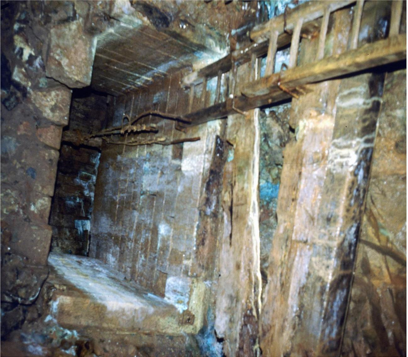
Illust 4 – concrétionnement contenant du sulfate de fer dans le puits de l'Engin, à Grandfontaine (Alsace). Photo H. Bari
