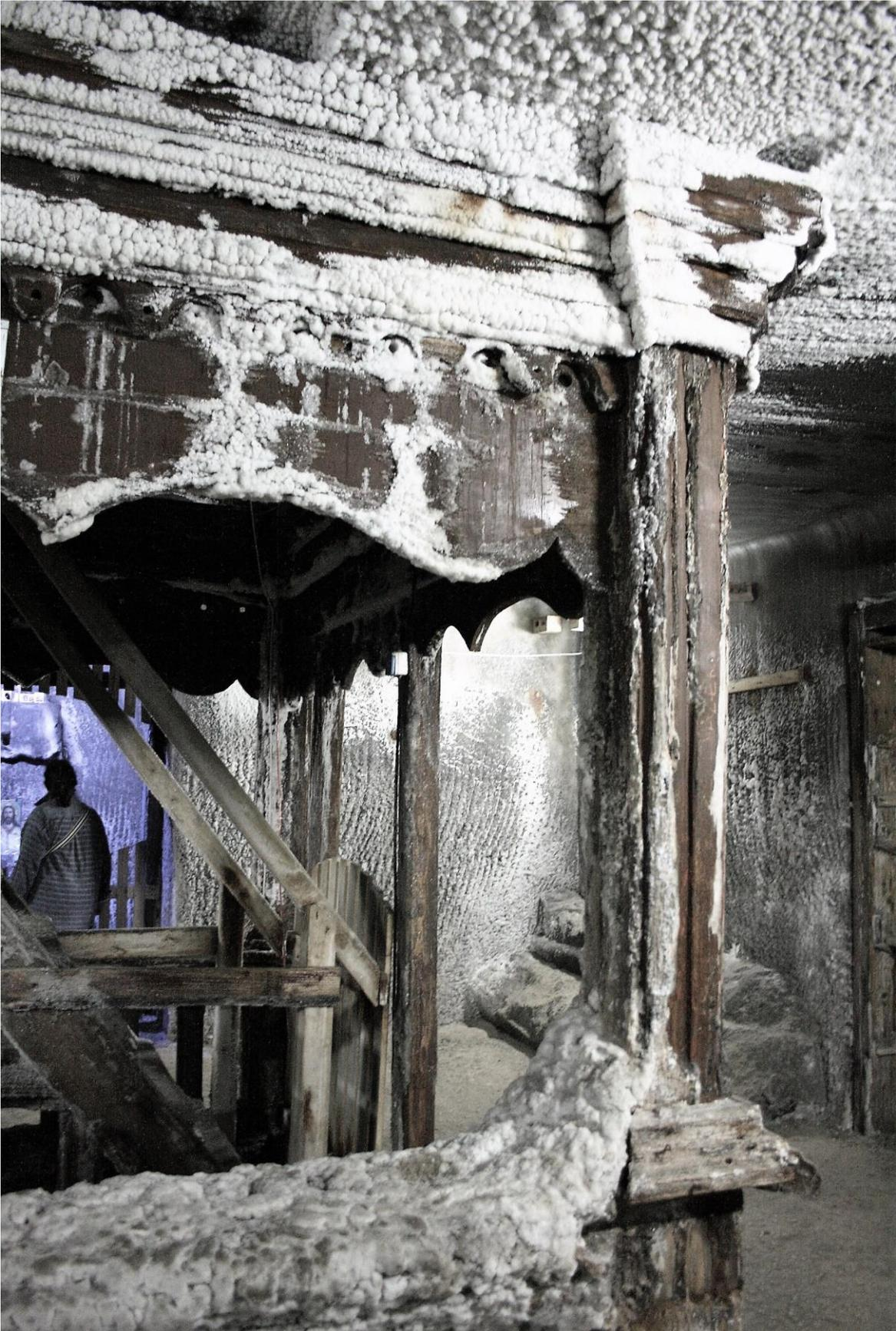
Illust 3 – concrétionnement de sel dans les installations souterraines d'une mine en Roumanie.
