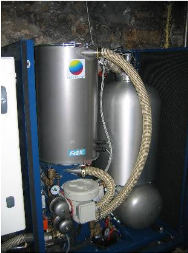
L'unité de micro-cogénération sans son capot de protection acoustique (à gauche) L'afficheur du wattmètre mesurant la puissance électrique produite (à droite)
