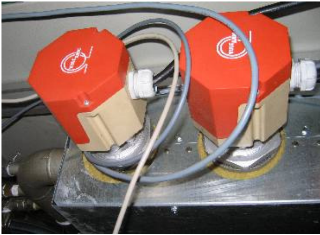
Résistances du réchauffeur (à gauche) et réservoir de granulé (à droite)
