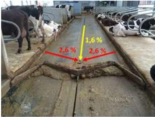
**Figure 7 :** Combinaison de pentes transversales (flèches rouges) et longitudinale (flèche jaune) sur la ferme de l'Institut de Genech (Gervais, à paraître <sup>e</sup>). Racleur à corde en W (marque CRD) pour capter le lisier par demi-couloir et limiter le passage de lisier dans le canal central lors du raclage.
