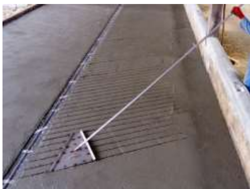
Figure 5 : Empreintes en arrêtes de poisson sur béton frais avec pentes transversales vers le canal.
