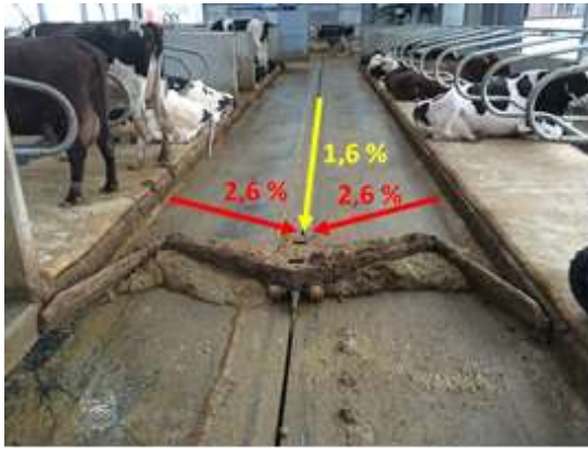
Figure 7 : Combinaison de pentes transversales (flèches rouges) et longitudinale (flèche jaune) sur la ferme de l'Institut de Genech (Gervais, à paraître e ). Racleur à corde en W (marque CRD) pour capter le lisier par demi-couloir et limiter le passage de lisier dans le canal central lors du raclage.
