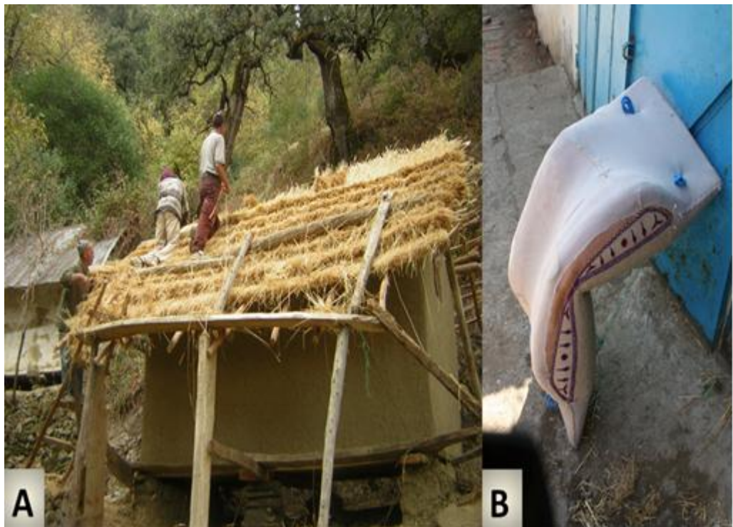
Figure 2 : Utilisations de la paille des céréales marginales : l'engrain pour les toitures (A) et le seigle dans la fabrication de bâts pour les animaux de charges (B)
