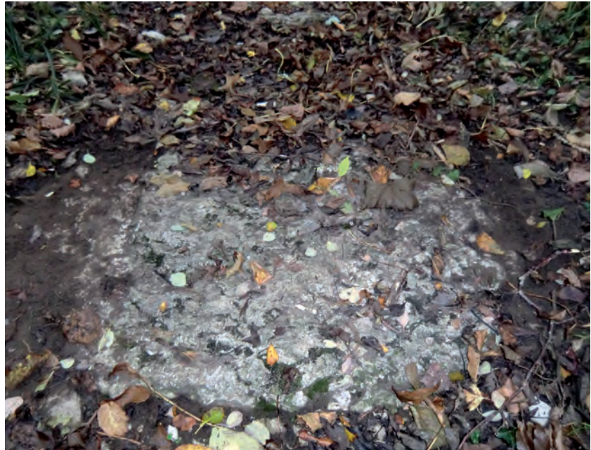
Fig.53 Ornière localisée au nord-est du plateau. P. Nouvel
