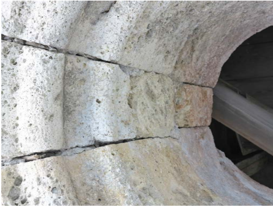
▲ Intrados d'une des baies B4.4 (UM4 - R+4)
