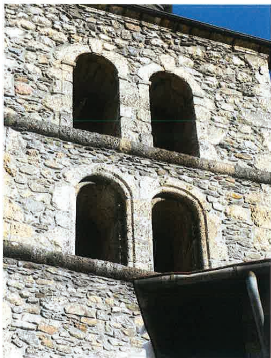
N°5 Baies de l'Élévation Sud Ouest
