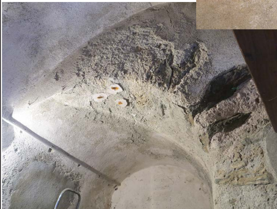
◀ Voute dans le mur UM4, accès à la porte P0.4 (RDC)
