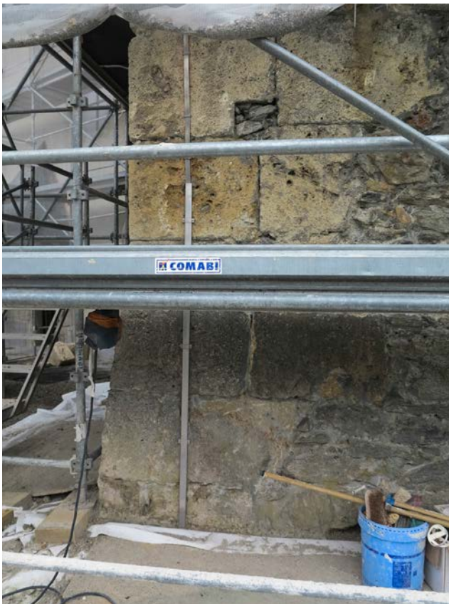
◀ Double chaînage d'angle au nord-est de l'UM2 (RDC)
