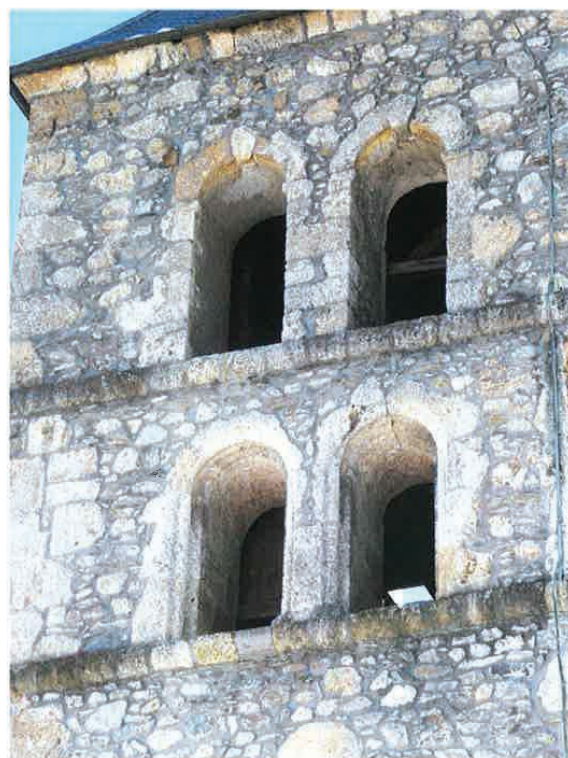
N°4 Baies Elévation Nord Ouest absence d'abat-sons
