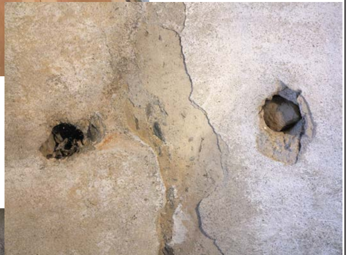
Détail des passages de corde dans la voute ▶
