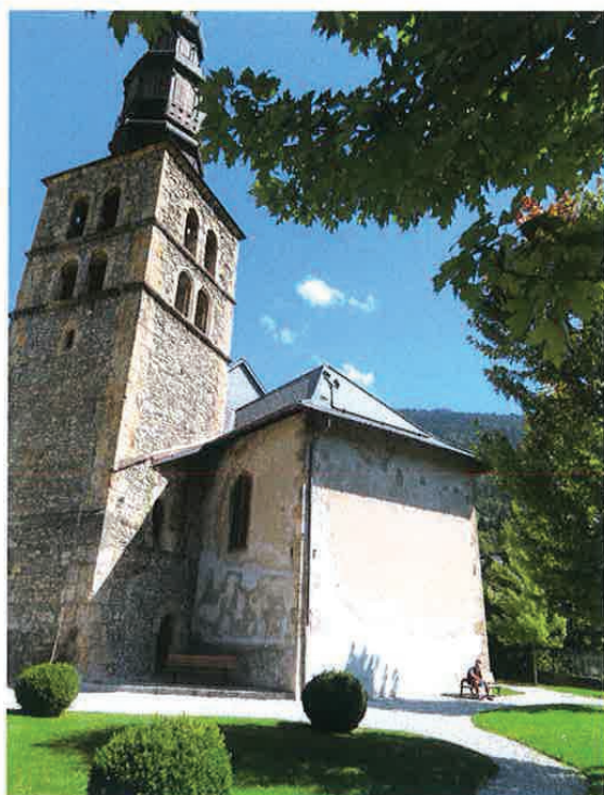
N°3 Angle Nord Ouest/Sud Ouest Clocher en maçonnerie apparente, les joints ont été repris au ciment
