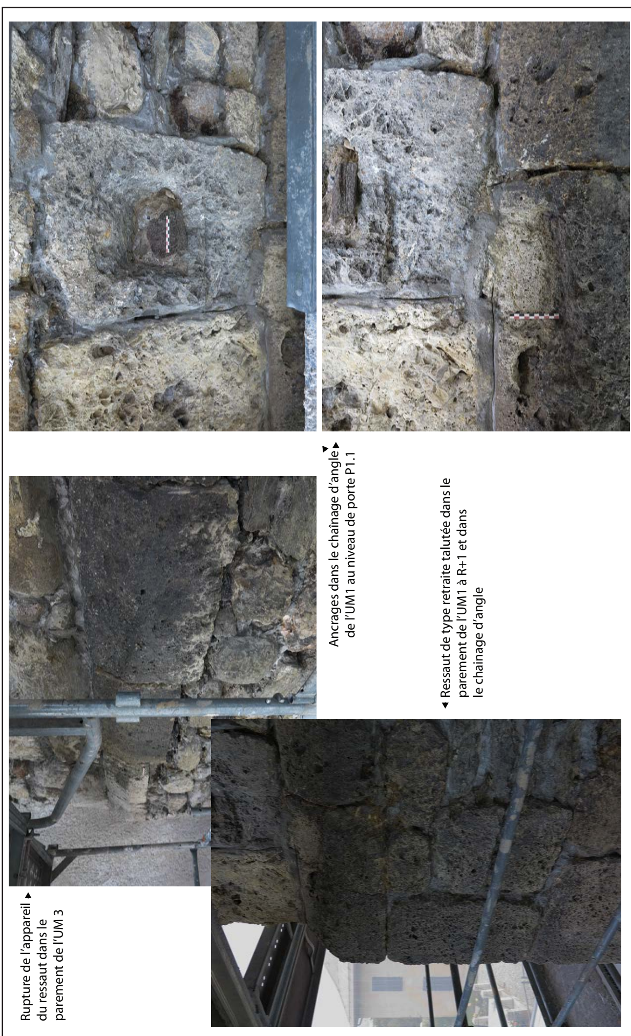
Figure 25 : Vues du ressaut R+1 dans les parements de l'UM1 et de l'UM3, détail des ancrages dans le parement de l'UM1 ; Photographies : Quentin Rochet
