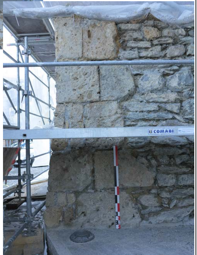
Double chaînage d'angle au nord-ouest ▶ de l'UM1 (RDC)
