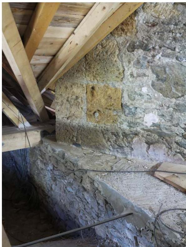
Chaînage d'angle dans le parement de l'UM4 ►
