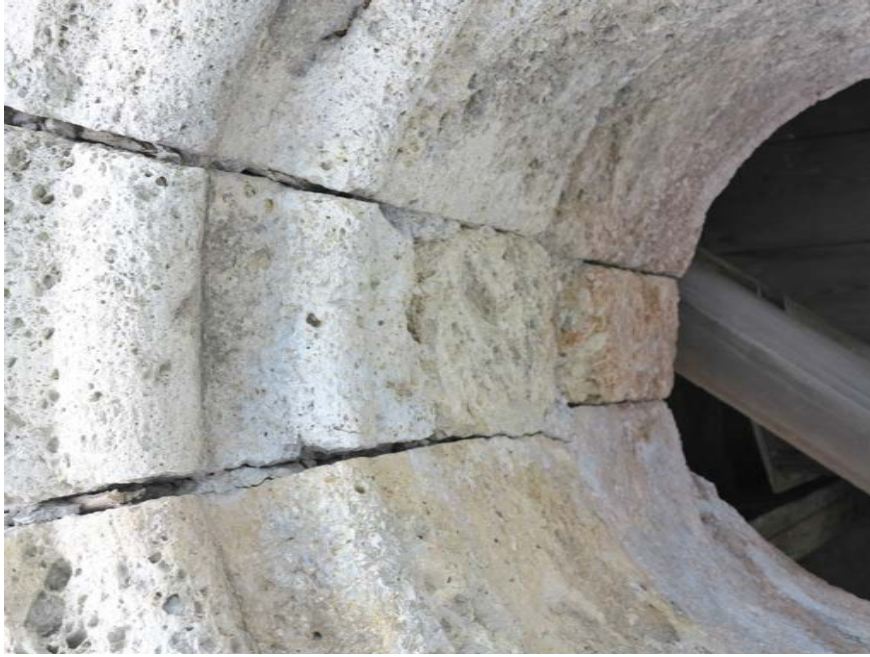
▲ Intrados d'une des baies B4.4 (UM4 - R+4)
