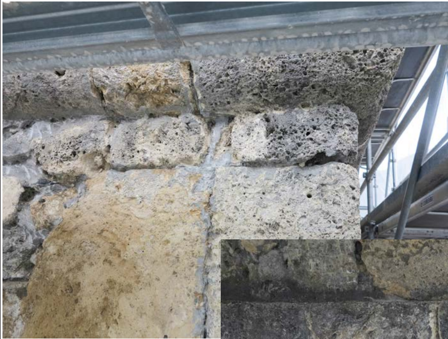
Profil de la corniche R+4 ► au sud-ouest de l'UM2
