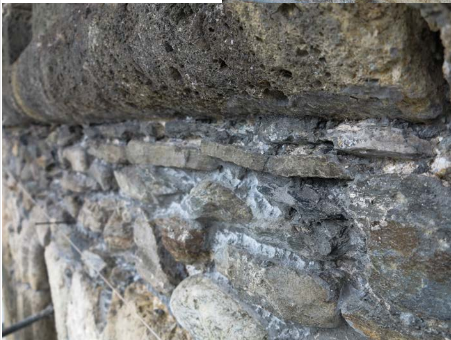
◀ Vue de détail du rattrapage d'assise de la corniche réinsérée R+5 (UM1 - UC 1.3)
