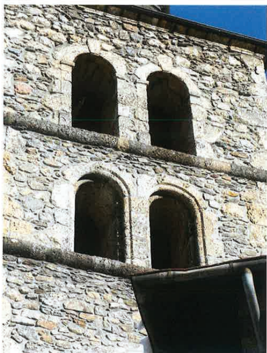
N°5 Baies de l'Élévation Sud Ouest
