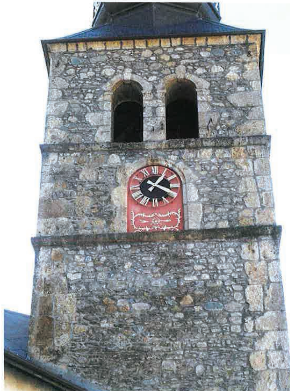
N°8 Haut de l'élévation Nord Est avec horloge
