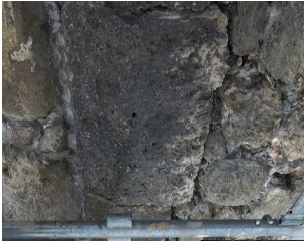
▲ Ancrages dans le chaînage d'angle de l'UM1 au niveau de porte P1.1
