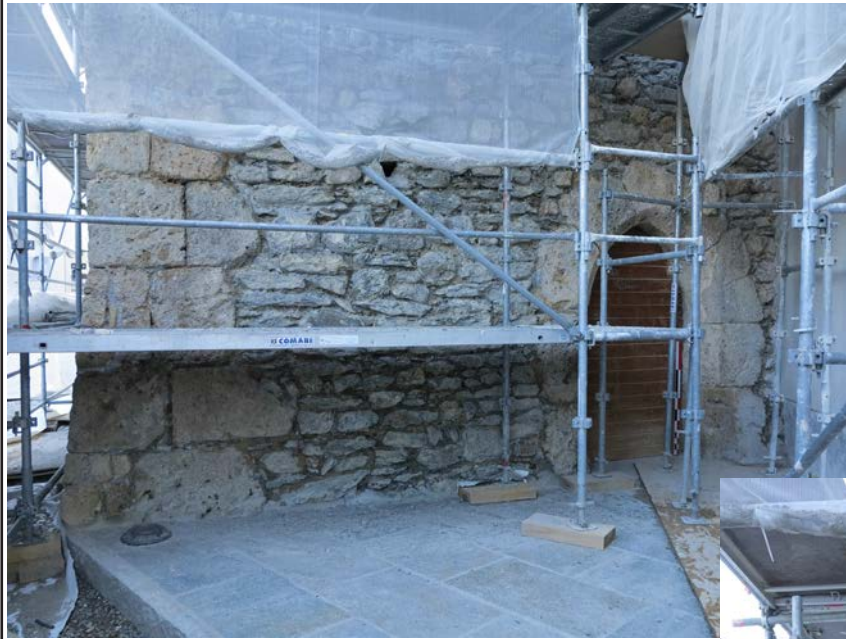
Double chaînage d'angle au nord-ouest ▶ de l'UM1 (RDC)
