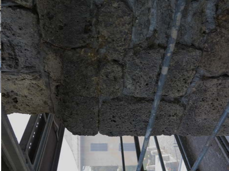
◀ Ressaut de type retraite talutée dans le parement de l'UM1 à R+1 et dans le chaînage d'angle
