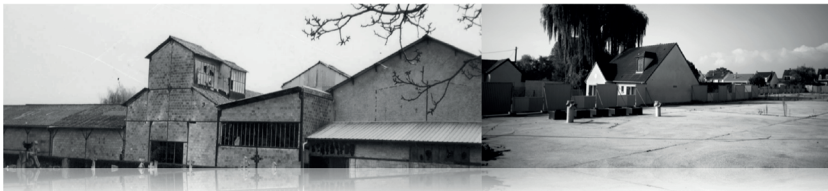
1a. bâtiments de l'usine visibles depuis le cimetière voisin
